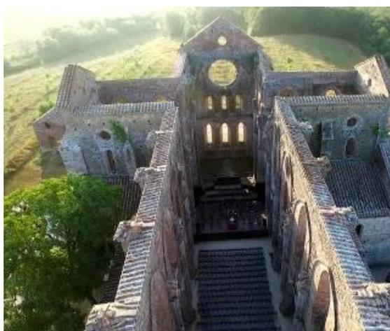
*Figura 133 - Proteção do topo das alvenarias com telhas com leve inclinação.*
