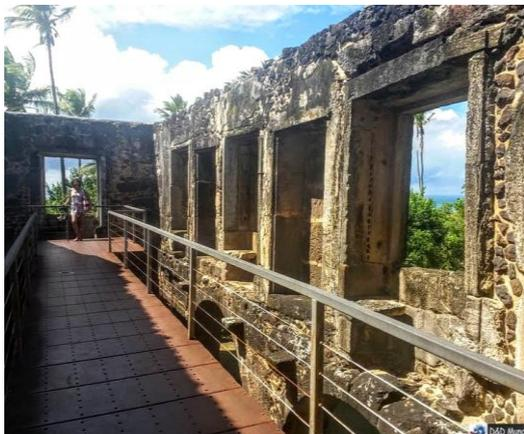
*Figura 130 - Passarelas metálicas suspensas nas ruínas.*
