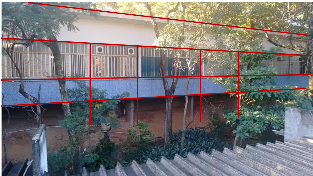
Fig.94 Vista da edificação que ocupa o Anexo. Foto: R. Laffite Data: Julho de 2018.
