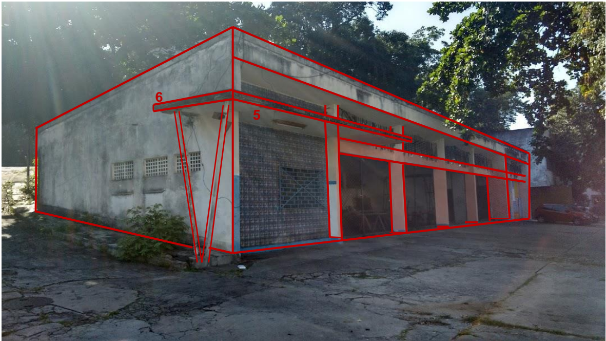
Fig.88 Edificação apresenta predominância linear. Foto: R. Laffite Data: Julho de 2018.
