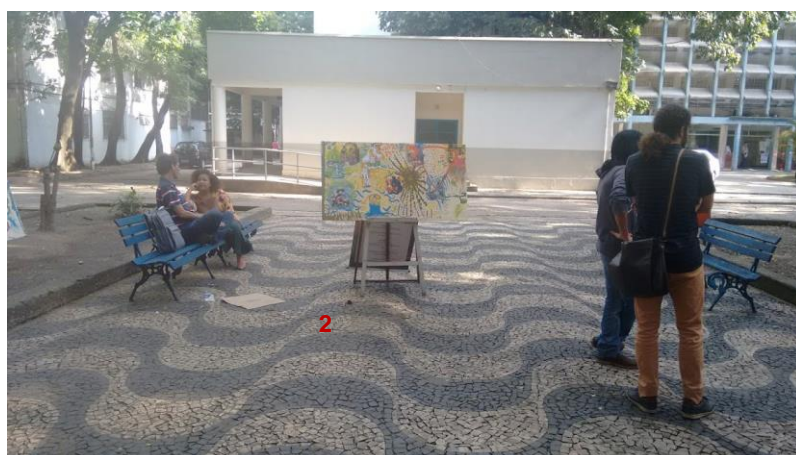
Fig. 62 Pavimentação em pedra portuguesa em frente ao acesso da edificação. Foto: R.Laffite Data: setembro de 2018.
