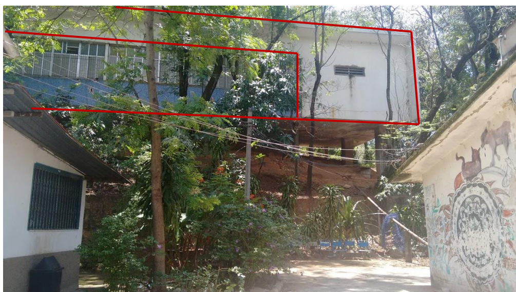
Fig.95 Vista do Anexo situado em terreno íngreme. R. Laffite Data: Julho de 2018.
