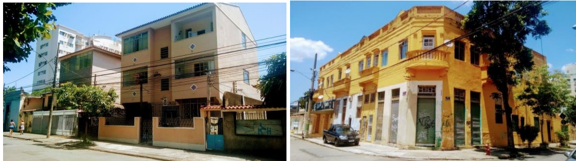
Fig. 57 Tipologias arquitetônicas no entorno da Rua Ramiro Magalhães. Foto: R. Laffite Data: outubro de 2018.
