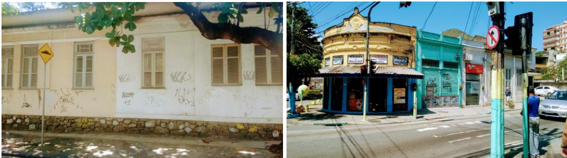
Fig. 58 Tipologia arquitetônica da Rua Dr. Leal e da Rua Borja Reis. Foto: R. Laffite Data: outubro de 2018.
