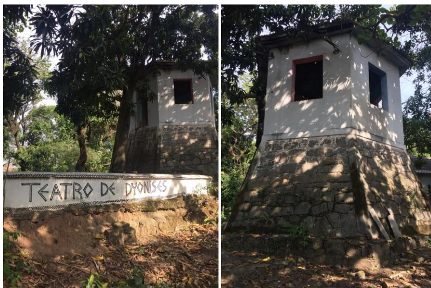
Fig. 74 Lago e Caixa d'água desativados, Espaço de convivo D. Foto: R.Laffite Data: julho de 2018.
