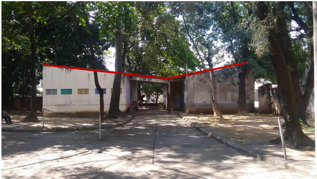
Fig.35 Vista de uma das edificações do Instituto com cobertura inclinada. Foto: R. Laffite Data: Outubro de 2018.
