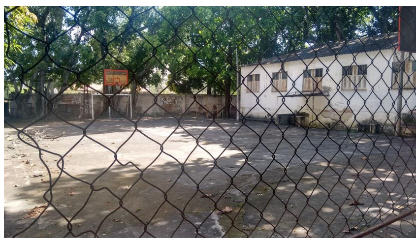
Fig. 80 Espaço de convívio F'' descaracterizada e com equipamentos deteriorados. Foto: R.Laffite Data: dezembro de 2018.
