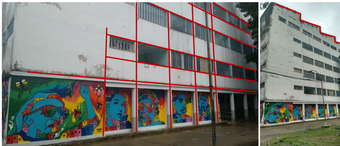
Fig.36 Edificação apresenta ritmo na cobertura e na fachada. Foto: R. Laffite Data: Outubro de 2018.
