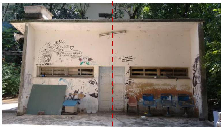
Fig.100 Fachada Simétrica (Sul), Casa de Bombas. Fonte: Elaborado pelo autor.
