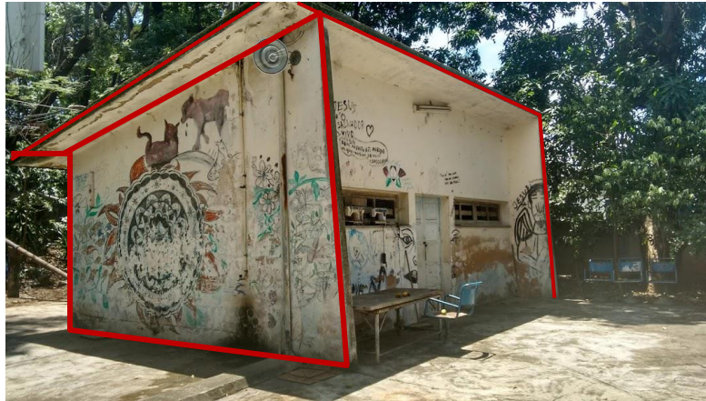
Fig.99 Casa de Bombas desativada. Foto: R. Laffite Data: Julho de 2018.
