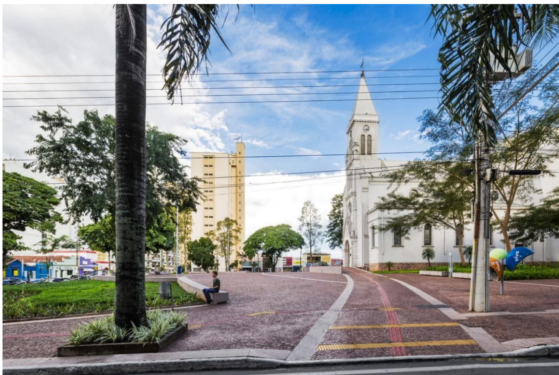
Figura 91 - Elevação de piso na Rua Cuiabá Fonte: ARCHDAILY
