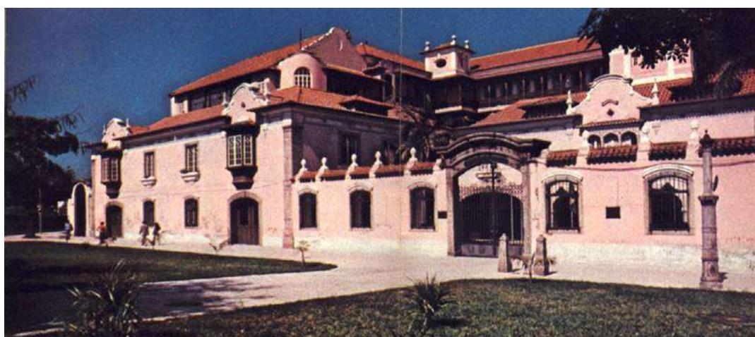
Figura 201 – O complexo do Pavilhão das Grandes Indústrias já em sua composição após as obras de ampliação para abrigar a Revista do Supremo Tribunal Federal (1924) e setores do Ministério da Agricultura (1928). Fonte: Arquivo pessoal do autor, s/d.
