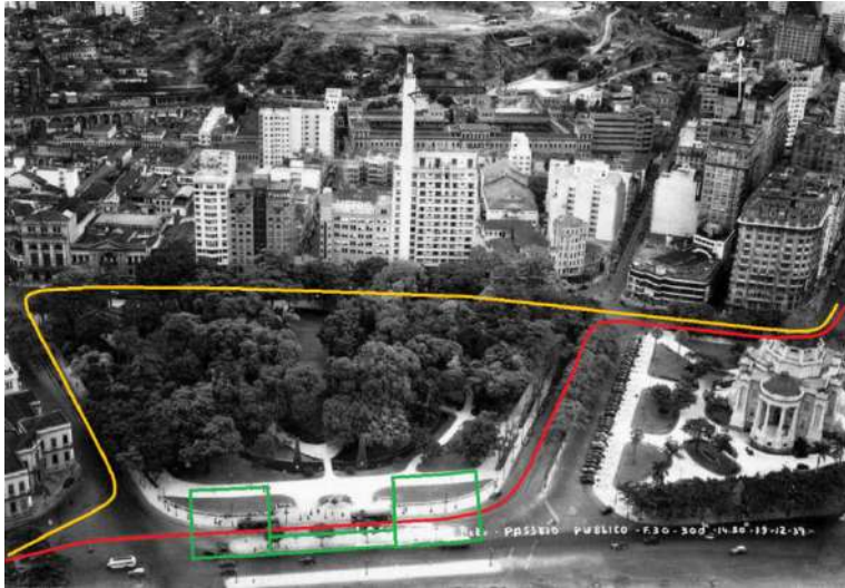
Figura 176 – Vista aérea do Passeio Público em 1939, após a demolição dos pavilhões e remodelação do tráfego. Em verde a localização dos pavilhões; em amarelo o antigo trajeto dos bondes, pela Rua do Passeio; e em vermelho o novo trajeto, pelas Ruas Luís de Vasconcelos e Mestre Valentim. Fonte: Acervo do Museu Aeroespacial, modificado pelo autor.
