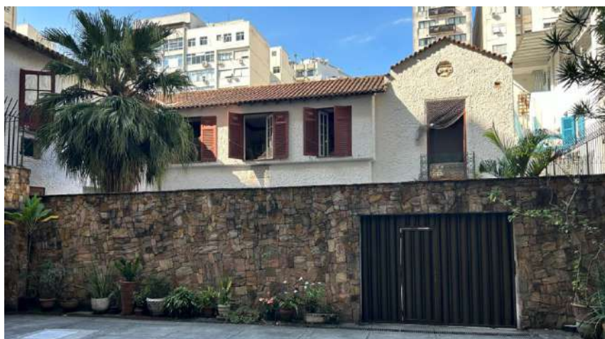
Figura 263 – Fachada frontal da residência de Archimedes Memória atualmente. Fonte: Foto do autor, 2023.
