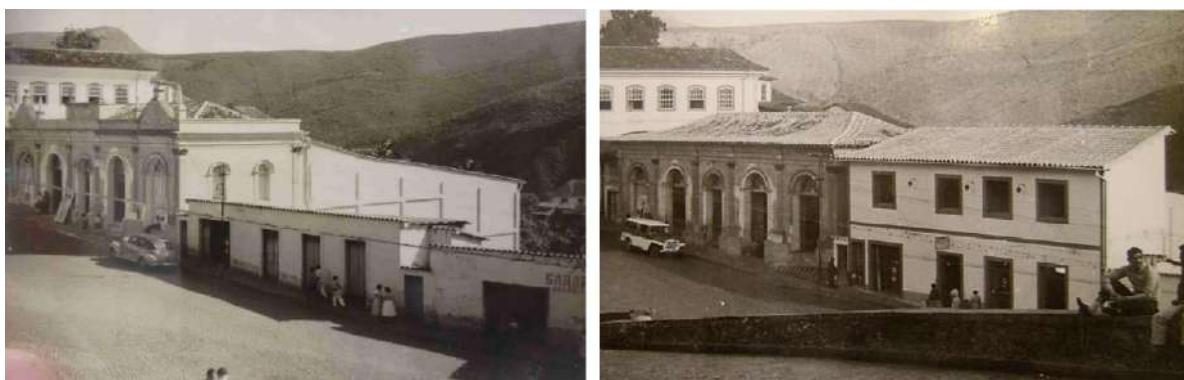
Figuras 495 e 496 – Prédio do Liceu em fase final das obras para cinema, com grande volume na parte posterior; e a solução encontrada por Vasconcellos com a construção de um segundo pavimento na edificação vizinha, em 1959. Fonte: Arquivo Central do IPHAN no Rio de Janeiro - Série Obras, Caixa 0218, Pasta 0946.
