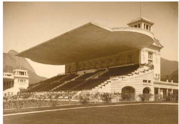
Figuras 297 e 298 – Hipódromo do Jockey Club - Tribuna dos sócios, destacando-se o vão em concreto armado, o maior da América Latina até aquele momento. Fonte: Acervo NPD-FAU/UFRJ.
