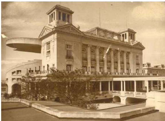
Figuras 297 e 298 – Hipódromo do Jockey Club - Tribuna dos sócios, destacando-se o vão em concreto armado, o maior da América Latina até aquele momento. Fonte: Acervo NPD-FAU/UFRJ.
