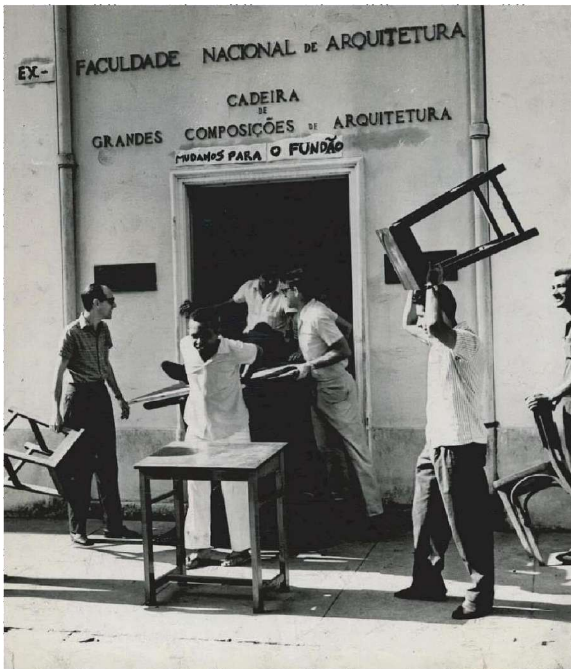
Figura 554 – Alunos retirando os bancos e pranchetas do Pavilhão Archimedes Memória, no Campus da Praia Vermelha, para a mudança para o novo edifício da Faculdade Nacional de Arquitetura, na Ilha do Fundão. Fonte: Correio da Manhã , 02 jul. 1961, p.2.
