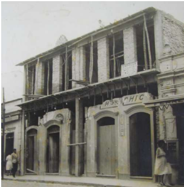
Figura 504 – Edificação à Rua Arthur Bernardes, 99, quase totalmente demolida, durante as obras. Fonte: Arquivo Central do IPHAN no Rio de Janeiro - Série Obras, Caixa 0278, Pasta 0793.
