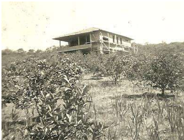
Figura 544 – Sítio Nosso Retiro durante a construção, em 1957. Na foto vê-se as fachadas frontal e lateral direita, além dos pés de laranja plantados por Archimedes ao redor da edificação. Fonte: Acervo pessoal de Péricles Memória Filho.
