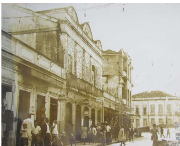
Figura 497 – Sobrado à rua Arthur Bernardes, 99 (ao centro), em 1963, antes das obras do IPHAN. Ao fundo, sobrado da Prefeitura Municipal. Fonte: Arquivo Central do IPHAN no Rio de Janeiro - Série Obras, Caixa 0278, Pasta 0793.
