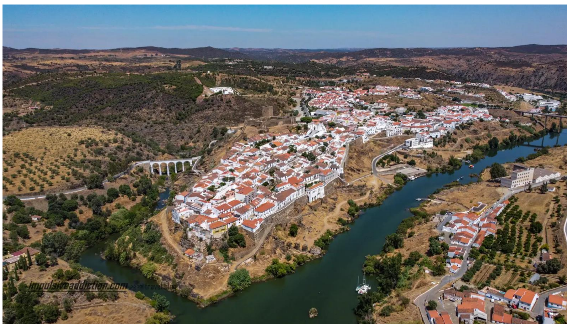
Figura 14- Vista aérea Vila de Mértola. Foto: Pedro Domingues. Fonte: Impulsive Addiction. Disponível em: https://www.impulsiveaddiction.com/mertola-o-que-visitar/
