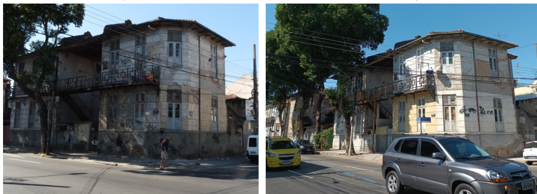
Figura 68: Fotografias da fachada lateral da quadra 07B voltada para a Rua Aníbal Benévolo 2011 2022
