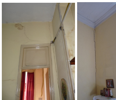
14. Paredes com trincas, fissuras e manchas de umidade
