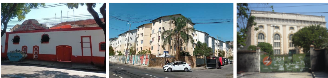
Figura 7: G.R.E.S Estácio de Sá, MCMV e Light Subestação Frei Caneca
