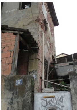
14. Paredes com trincas, fissuras e manchas de umidade
