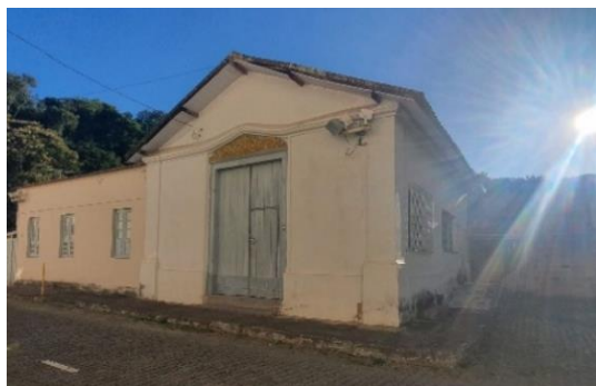
Figura 48: Fachada original da Capela Nosso Senhor dos Passos. Fonte: Autora, 2020.
