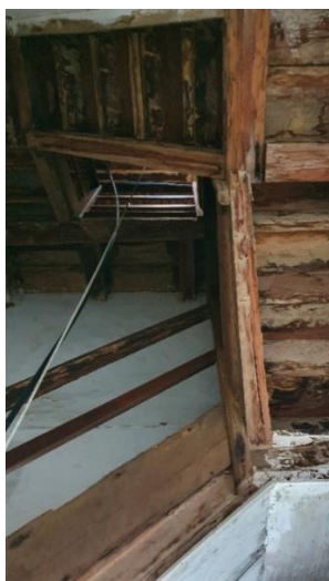
Detalhe construtivo da escada de acesso ao campanário. Fonte: Autora, 2022
