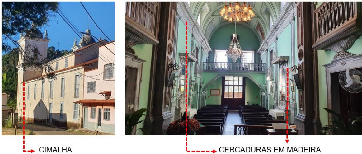
Figura 43: Ornamentos na fachada lateral e no interior da Igreja Sant'Ana. Fonte: Autora, 2020.
