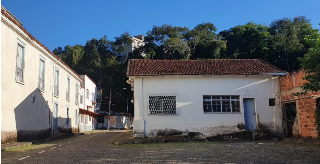
Figura 141: Esquadrias existentes na antiga Capela Senhor dos Passos Fonte: Autora, 2021
