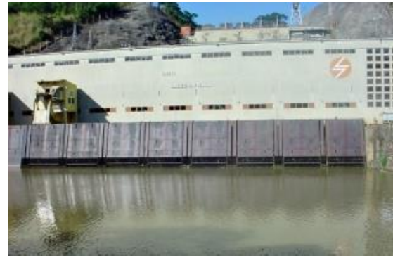
Estação elevatória de Vigário em Pirai. Foto: Floriano de Oliveira, 2005. Fonte: Light.
