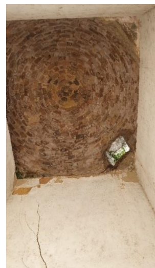
Detalhe construtivo do interior da cúpula. Fonte: Autora, 2022
