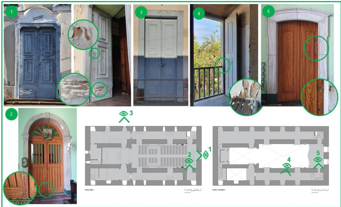
Figura 62: Identificação de danos nas esquadrias - portas. Fonte: Autora, 2022
