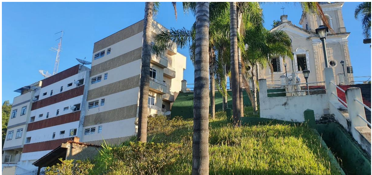
Figura 90: Edificações com gabarito elevado interferem na visibilidade da Igreja Sant’Ana. Fonte: Autora, 2021.
