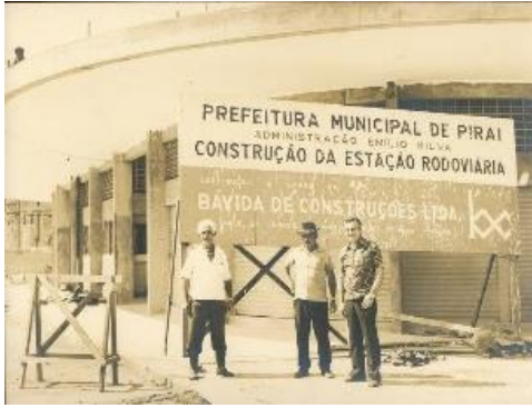
Construção da estação rodoviária, 1972. Fonte: Light
