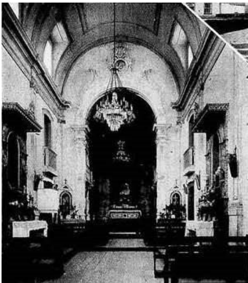
Figura 15: Interior da igreja de Sant'Ana com o teto liso. Fonte: Arquivo Municipal, 1933.
