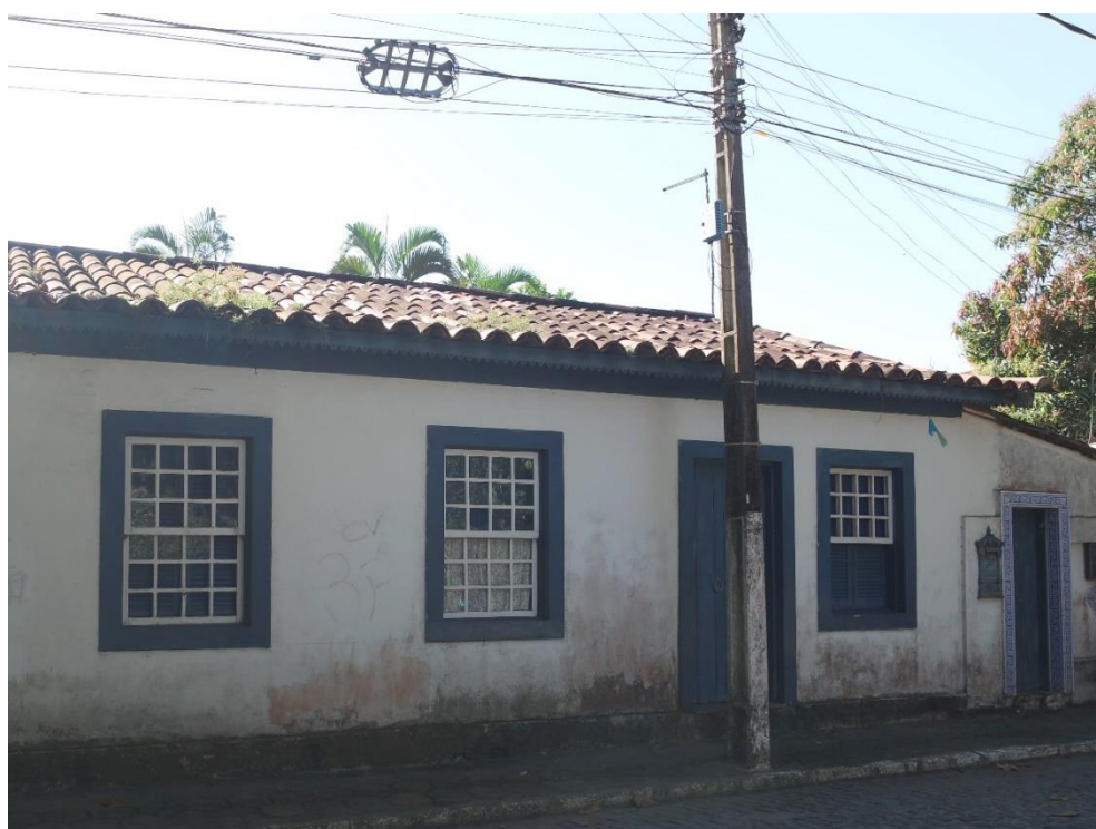
Figura 110: Vista de posteamento na rua São João. Fonte: Acervo do autor, 2023.
