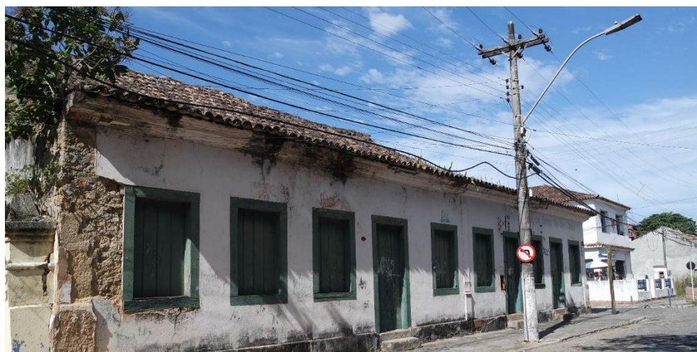
Figura 111: Vista de posteamento na rua Bernardo Gomes. Fonte: Acervo do autor, 2023.
