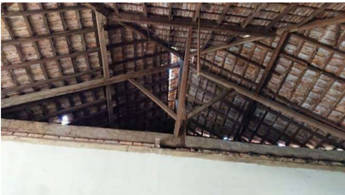
Figura 67. Detalhe da estrutura de cobertura.
