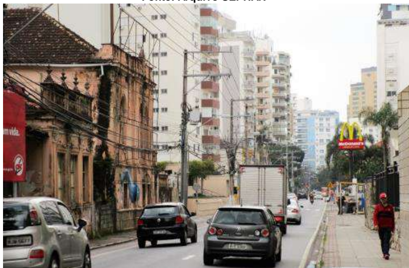
Figura 21. Fotografia da Rua Frei Caneca, em 2016. À esquerda, a fachada das casas ecléticas estudadas. Fonte: https://ndmais.com.br/noticias/memoria-de-florianopolis-casarao-de-vidal-ramos-a-espera-de-restauracao/
