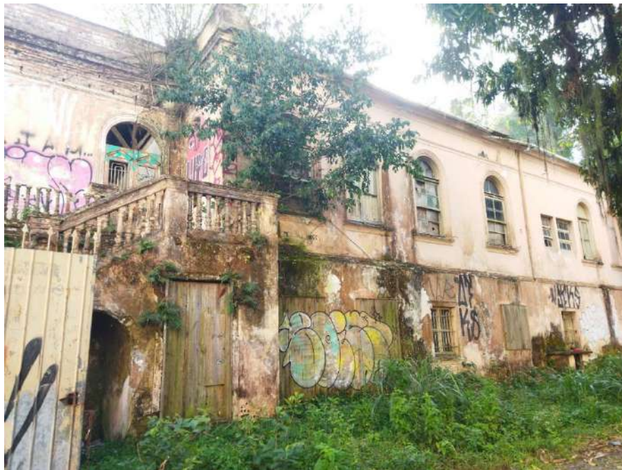
Figura 61. Fachada lateral/sul (a)
