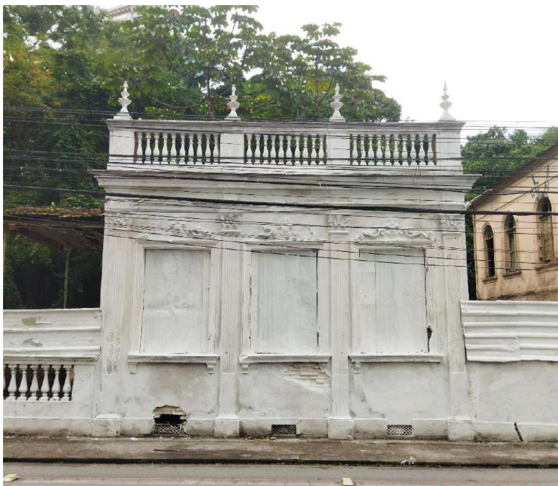
Figura 53. Casa térrea – fachada frontal /oeste.
