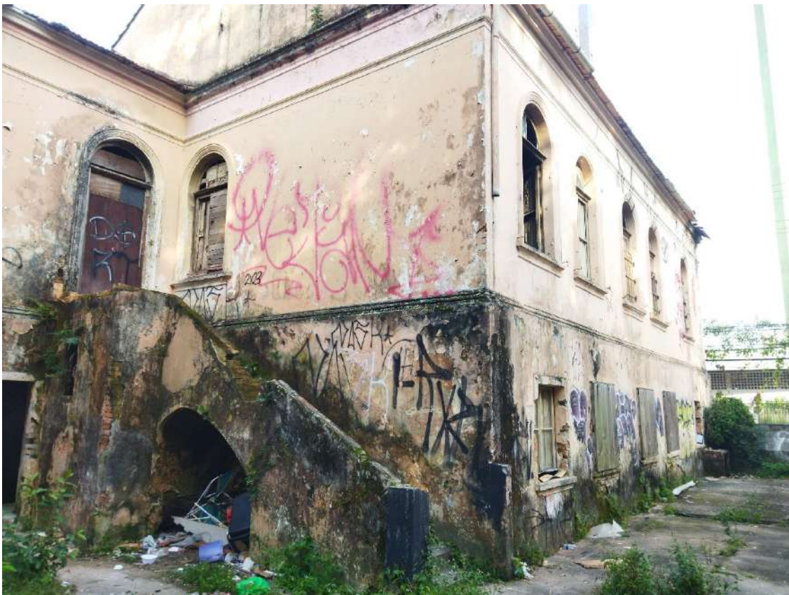
Figura 65. Fachada lateral/norte – sobrado.
