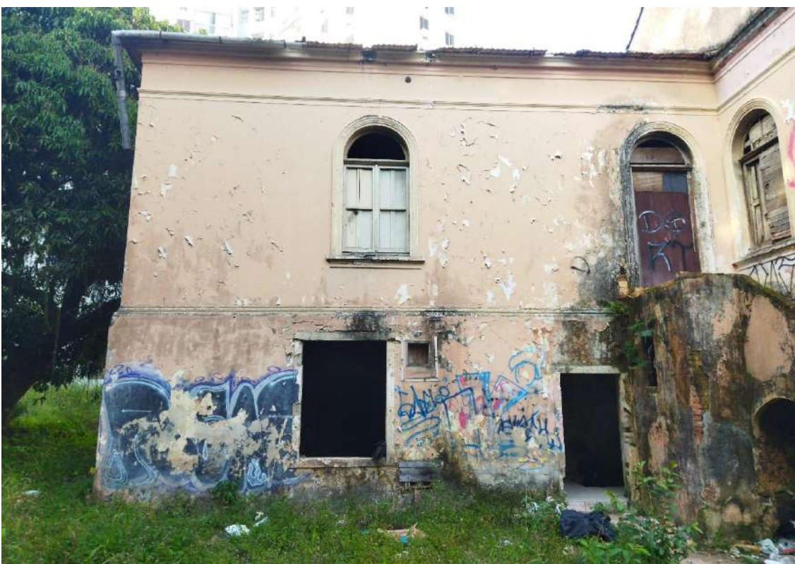
Figura 66. Fachada lateral/norte – detalhe dos fundos – sobrado.
