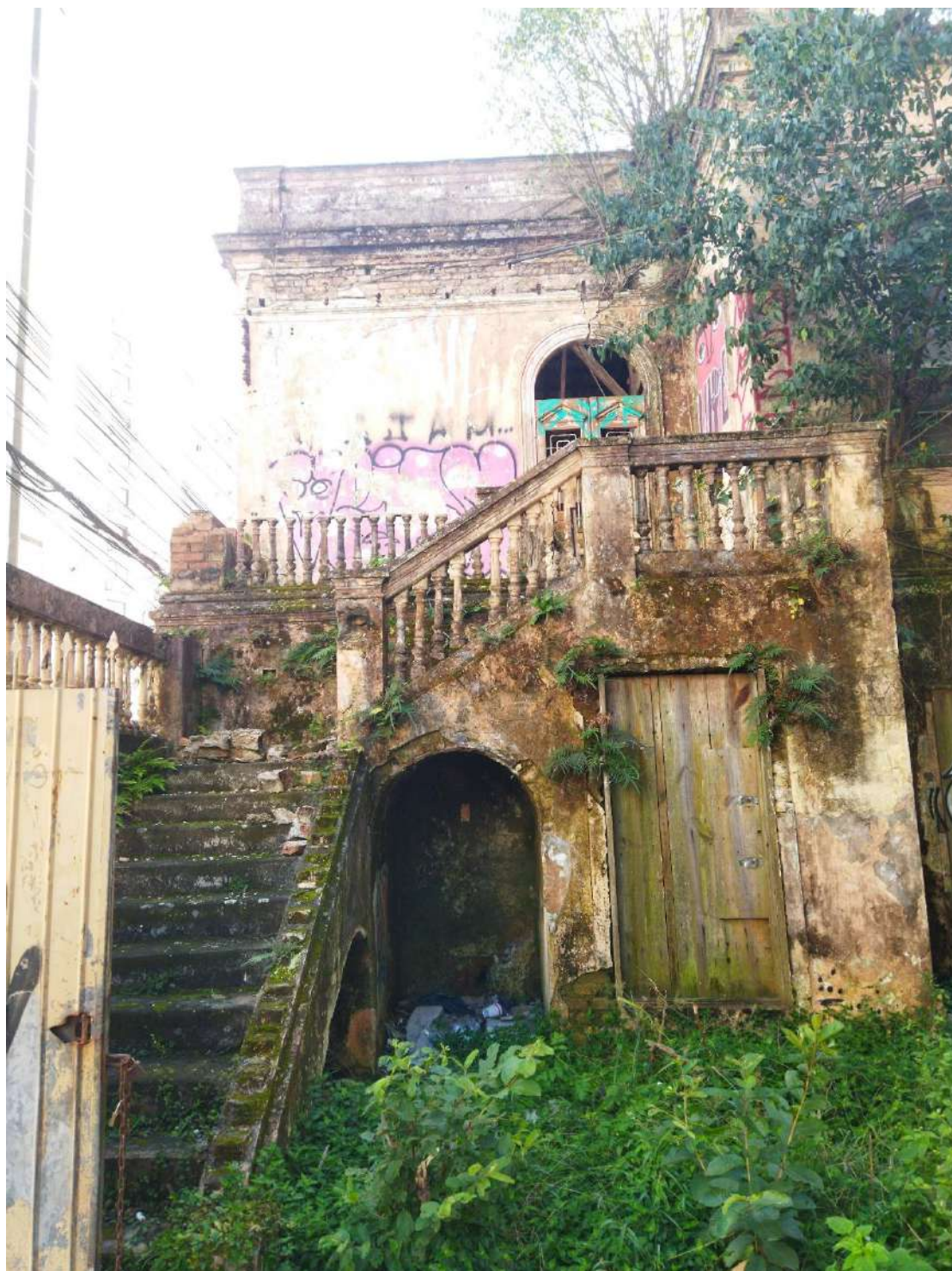
Figura 63. Fachada lateral/sul – detalhe da escada.
