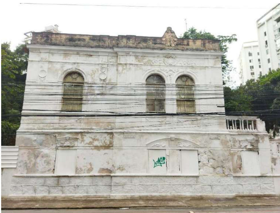
Figura 60. Sobrado – fachada frontal/oeste
