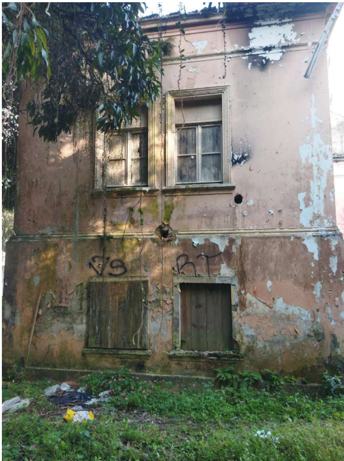
Figura 64. Fachada dos fundos.
