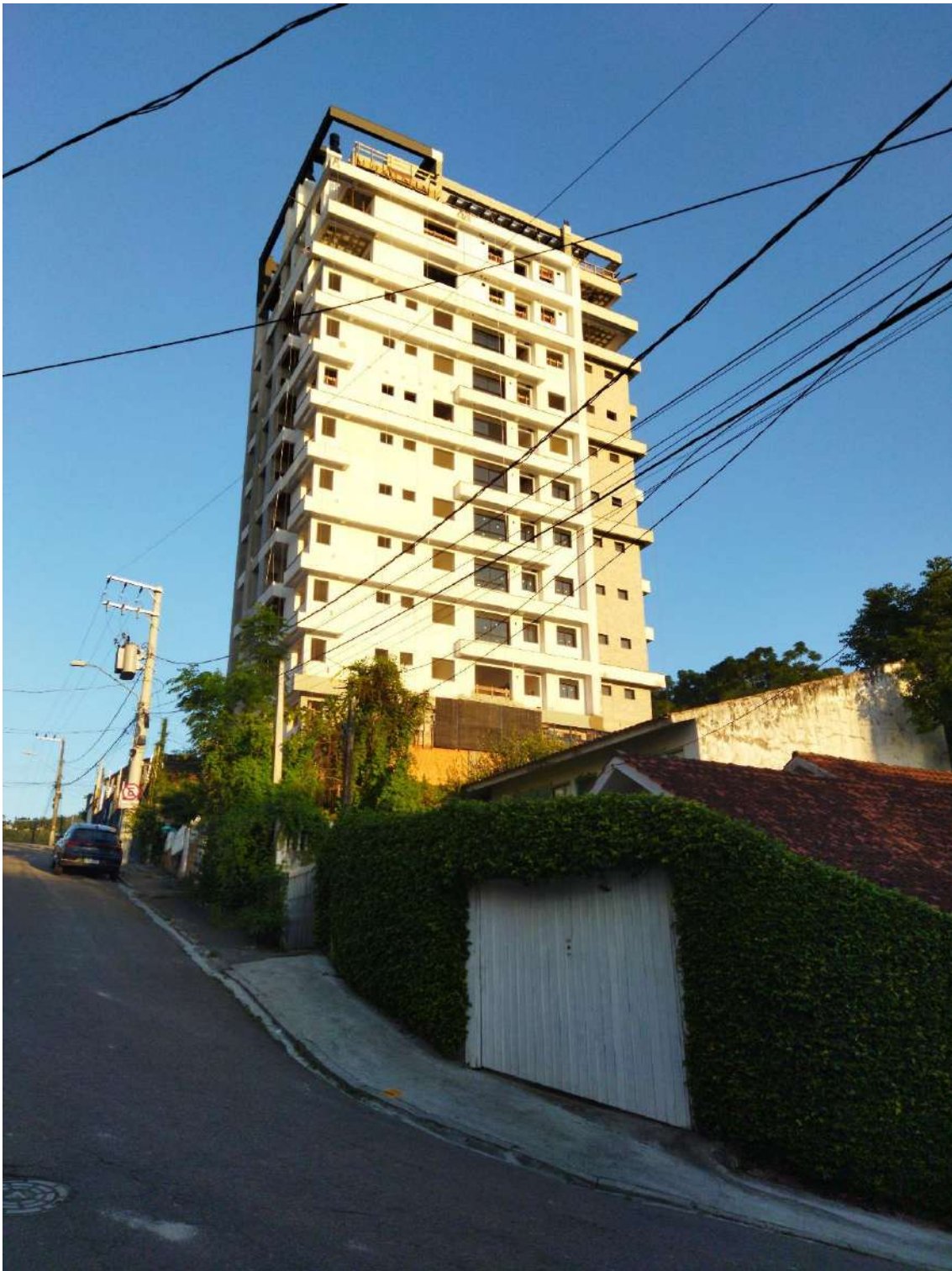
Figura 46. Construção de edifício verticalizado na Rua Padre Schrader. Fonte: Autora (2024).
