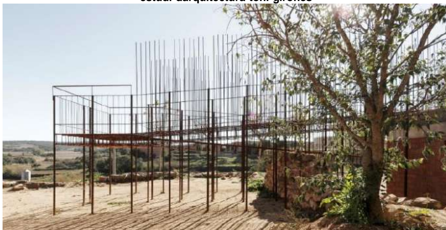
Figura 85. Detalhe da rampa.
