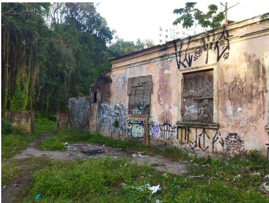
Figura 56. Casa térrea – fachada lateral/norte – fundos.
