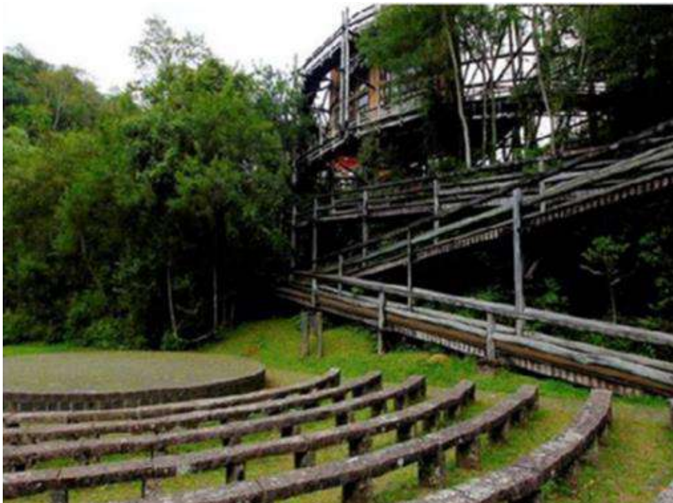
Figura 77. Vista do auditório ao ar e da edificação sede. Fonte: SILVA; TERIBELI, 2018, p. 133.
