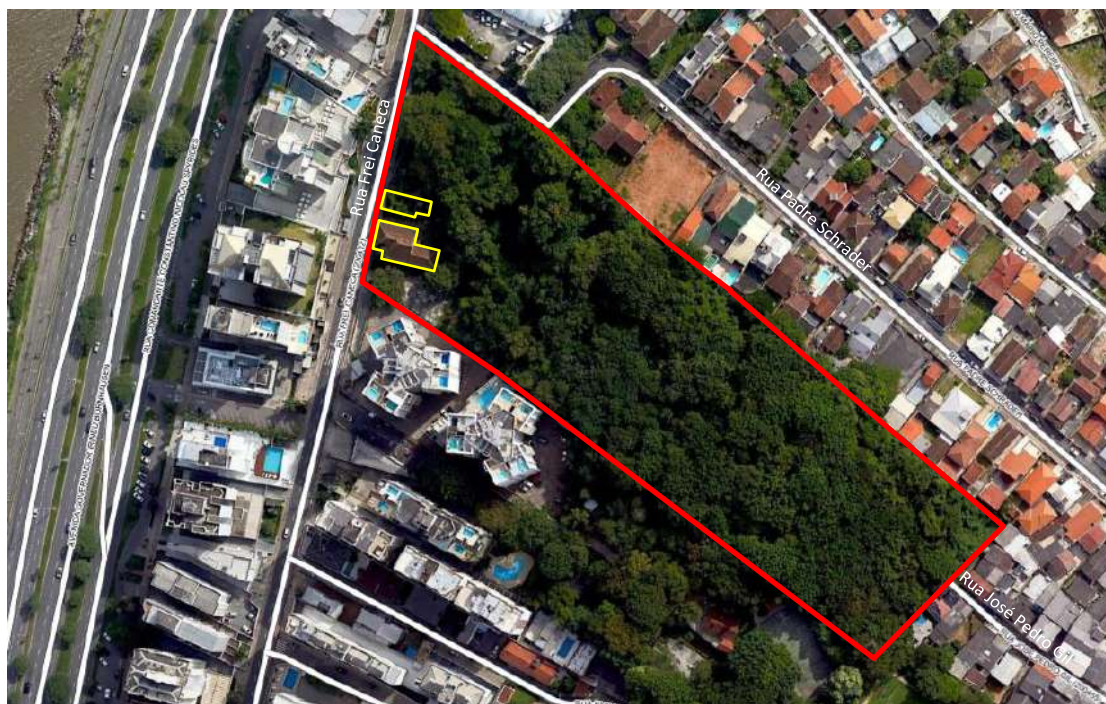
Figura 3. Vista aérea do conjunto arquitetônico e paisagístico da Rua Frei Caneca, s/n, (em vermelho) com destaque das edificações ecléticas remanescentes no terreno (em amarelo) e identificação das vias de acesso. Fonte: PMF, 2023 < http://geo.pmf.sc.gov.br/index.php > Edição da autora.
