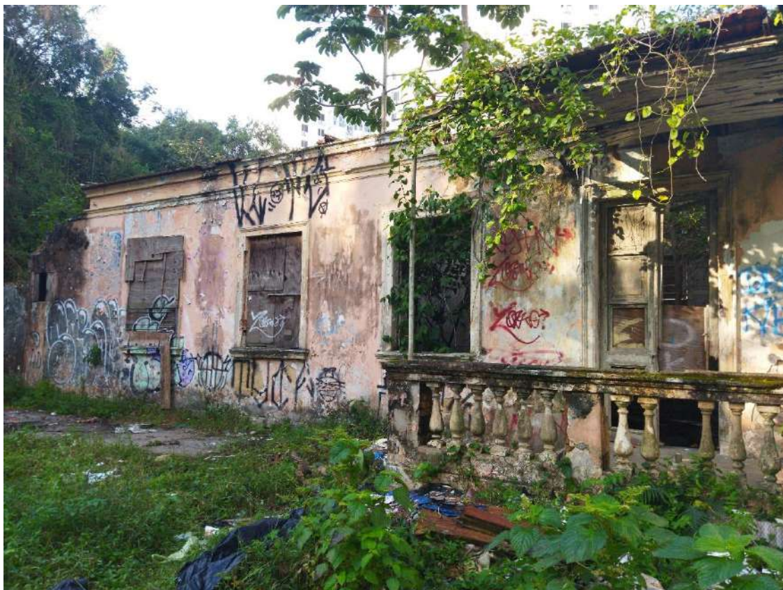
Figura 55. Casa térrea – fachada lateral/norte.
