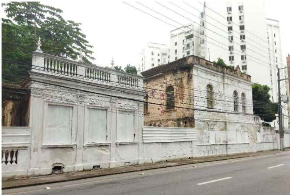
Figura 25. Edificações ecléticas na Rua Frei Caneca, s/n (A, B). A esquerda, a casa térrea, à direita, o sobrado de porão alto.
