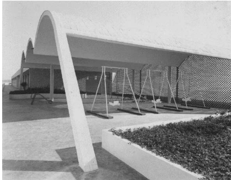
Figura 44 - Cobertura do bloco B, com destaque para os canteiros e as alterações nos pilares das abóbadas. Fonte: NPD-FAU.
