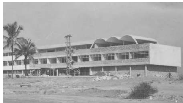
Fachada em construção no bloco B
