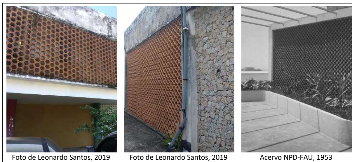
Quadro 21 - Respectivamente: painel do bloco D, painel do solário e painel da biblioteca (demolido). Fonte: indicada na imagem.
