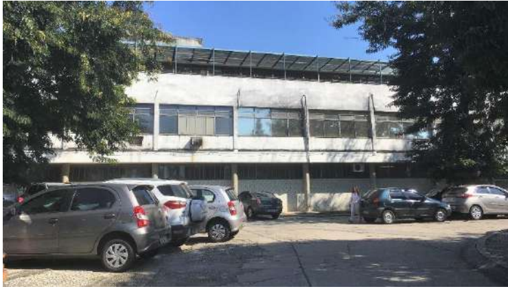
Fachada nordeste do bloco B, com pergolado em madeira instalado posteriormente na cobertura.
