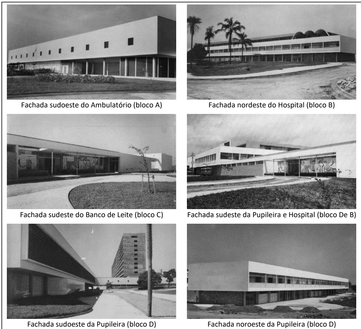
Quadro 8 – Diferentes fachadas do edifício. Fonte: NPD-FAU.
