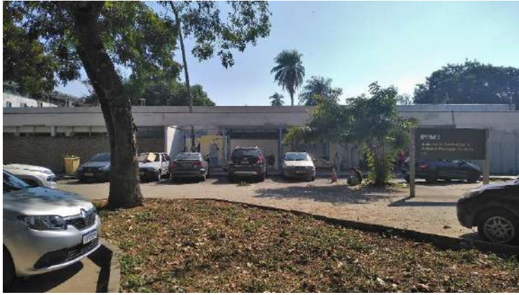
Fachada nordeste do bloco C.
