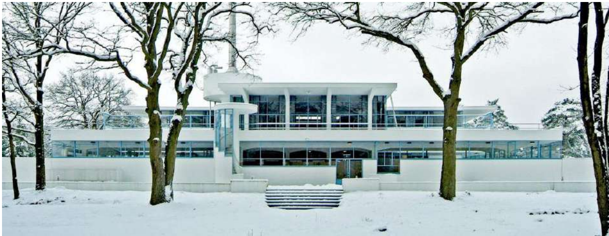
Figura 12 - Fachada restaurada. Fonte: autor desconhecido, disponível em https://www.zonnestraalhilversum.nl/zonnestraal-in-hilversum-the-netherlands/#top
