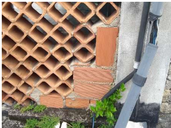
Painel de cobogós na cobertura do bloco B
