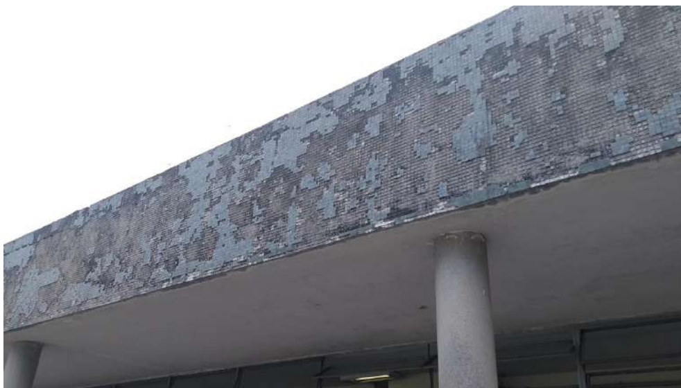
Figura 112 - Revestimento em pastilhas de vidro azuis na platibanda da cobertura do bloco B.
