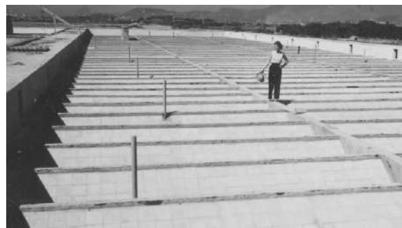
Cobertura em sheeds de concreto (bloco A)
