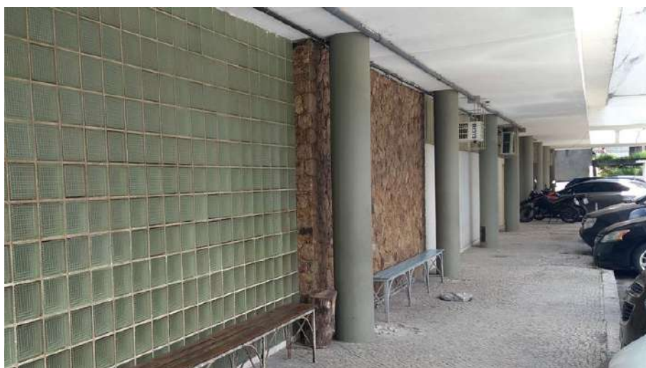
Figura 71 - Fachada do térreo do bloco D. Fonte: foto de Leonardo Santos, 2019.
