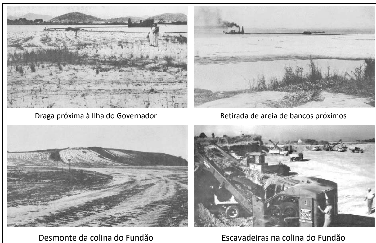
Quadro 6 – Desmonte da colina e aterramento da Ilha do Fundão, 1951. Fonte: NPD-FAU.
