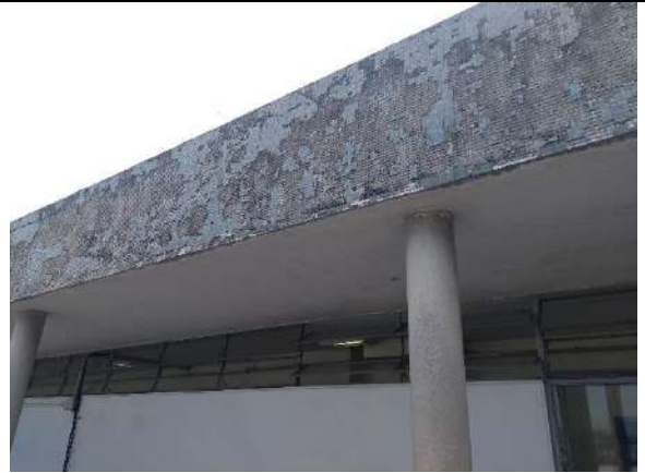
Pastilhas de vidro na cobertura do bloco B
