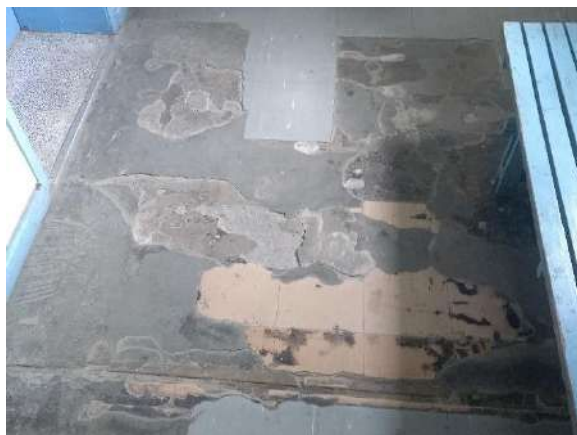
Camadas de revestimentos de piso
