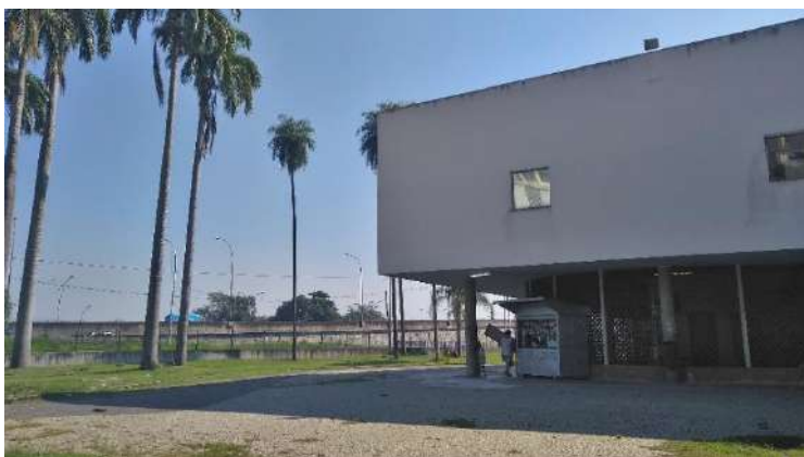
Fachada nordeste do bloco A.
