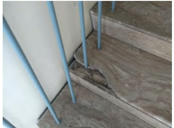
Degraus em mármore nas circulações verticais
