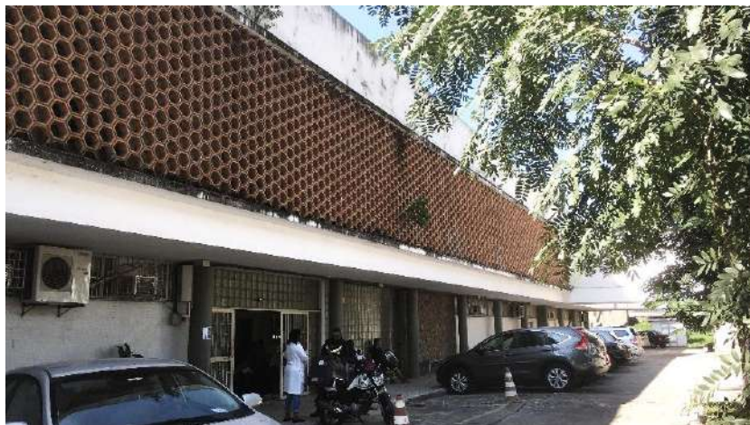
Figura 115 - Painel de cobogós do bloco D. Fonte: foto de Leonardo Santos, 2019.
