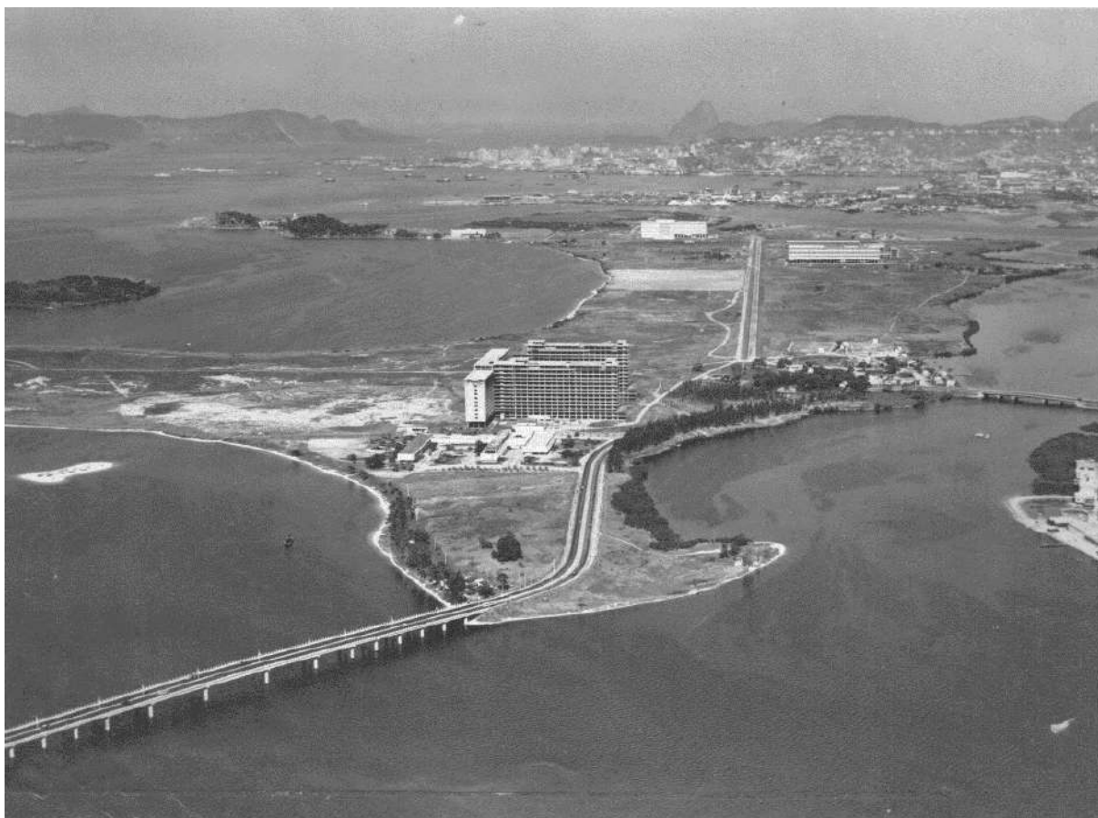
Figura 26 - CIDUNI durante a conclusão dos aterramentos na década de 1960. Fonte NPD–FAU.
