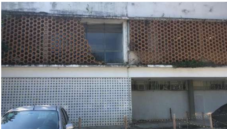
Fachada sudoeste do bloco D. Trecho com interdição devido ao perigo de queda dos cobogós.
