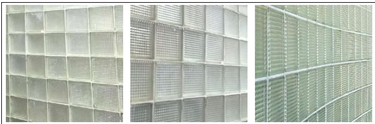
Quadro 34 - Alvenarias em blocos de vidro. Fonte: Leonardo Santos, 2021.
