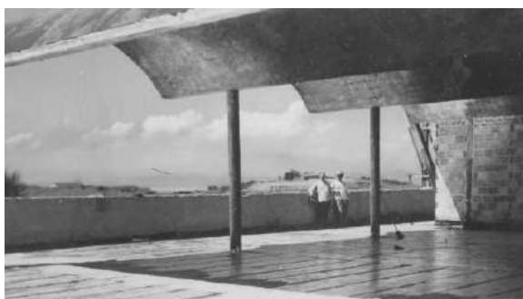
Abóbadas e impermeabilização do bloco B
