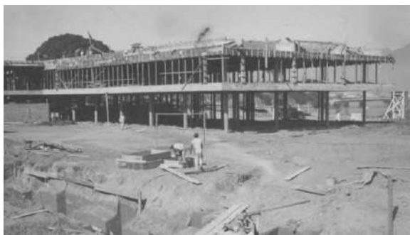
Concretagem do bloco A e fundações do bloco B
