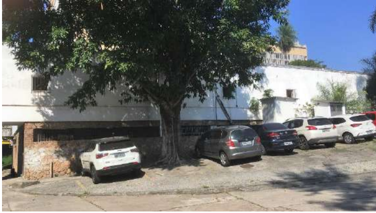
Fachada noroeste do bloco C.
