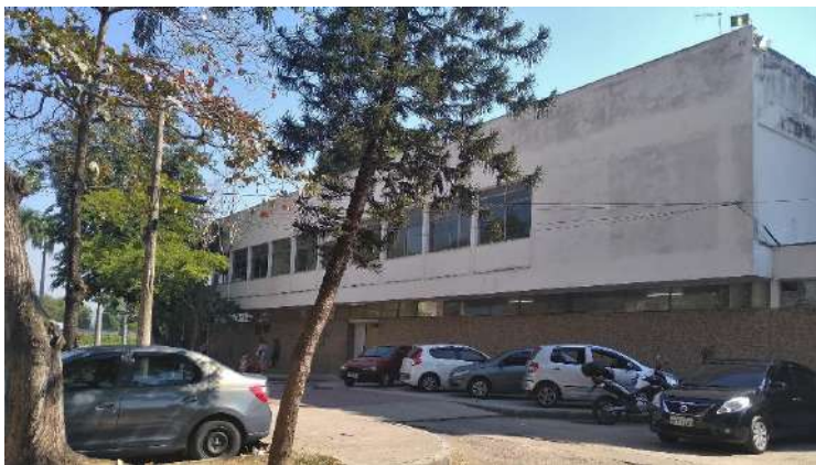
Fachada nordeste do bloco B.
