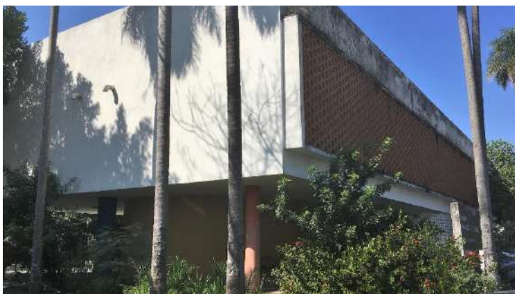
Fachada noroeste do bloco D.
