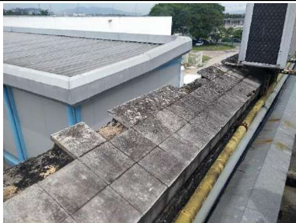
Cerâmicas de topo das platibandas
