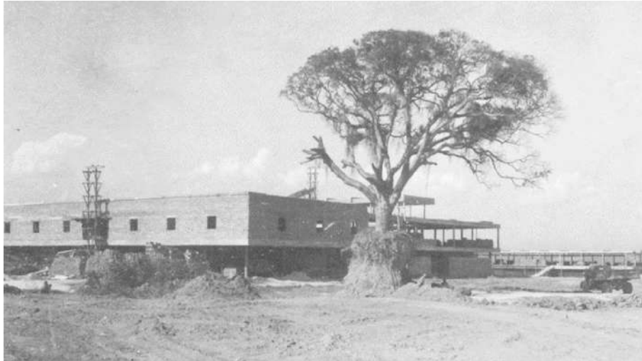
Figura 40 - Árvore existente expondo nível original do solo. Fonte: NPD-FAU.
