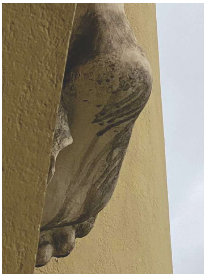
Figura 87: Imagem de detalhe do bem integrado a fachada. Sujidade-chuva-vento.
