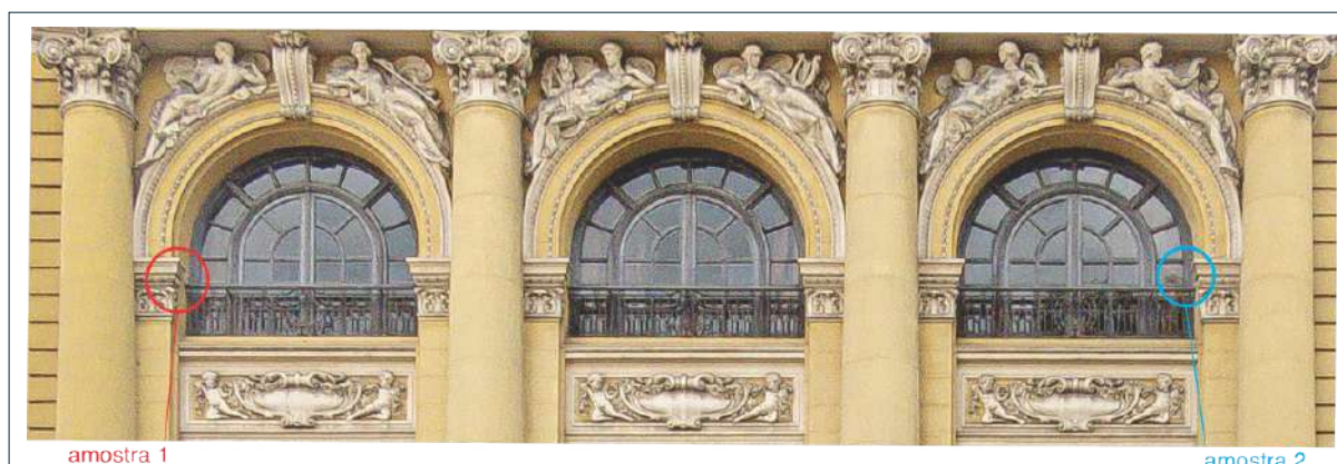
Figura 97: Locais de coleta de amostras na fachada da EM, para análise laboratorial.
