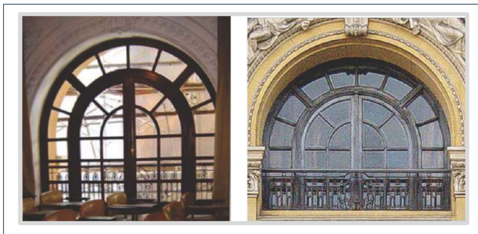
Figura 30: Janelas do Salão da Congregação, vista interna e externa.
