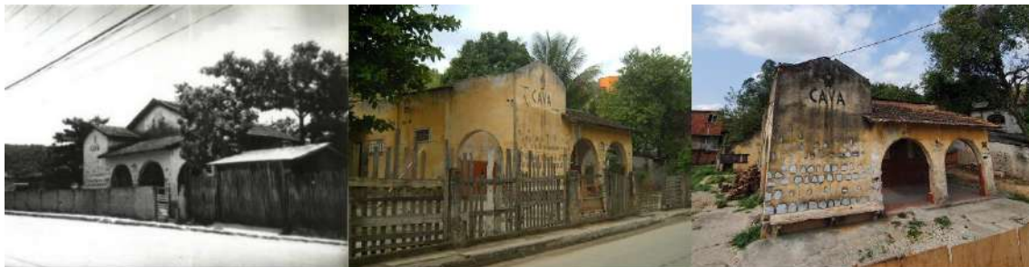
Figura 96: (a) A estação em 1989. Fonte: Acervo INEPAC. 1989. (b) A estação no ano de 2007. Fonte: Foto de Juliana Pavan. 2007. (c) A estação no ano de 2021. Fonte: Foto do autor. 2021.
