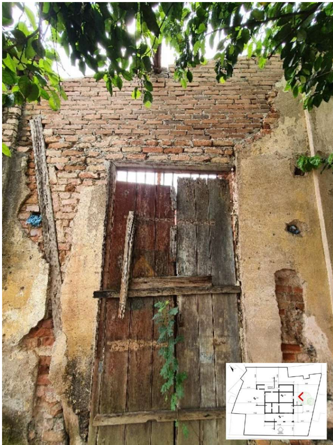
Figura 79: exemplo de parte da parede de tijolos maciços em face externa da estação. Fonte: Foto do autor. setembro de 2021.
