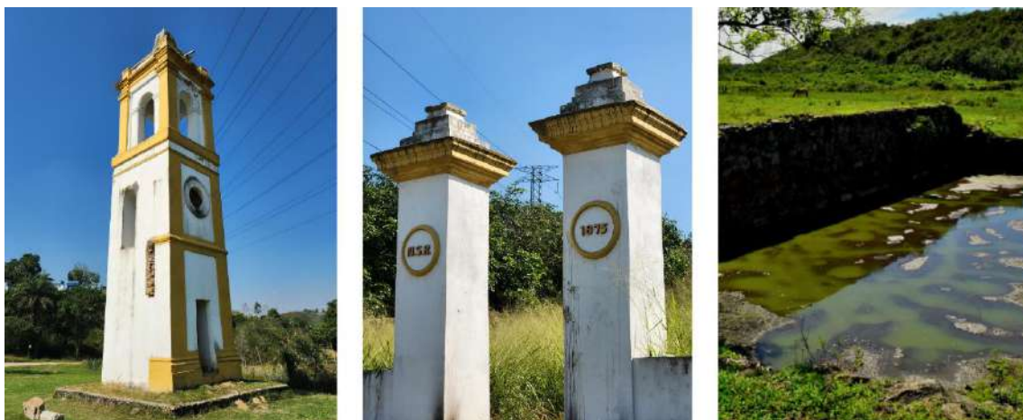
Figura 20: Ruínas do conjunto da antiga Vila de Iguassú. Torre sineira, cemitério dos escravizados e o antigo porto.
