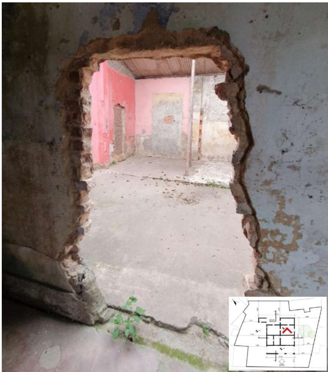
Figura 89: Parede interna original com abertura de vão. Fonte: Foto do autor. setembro de 2021.
