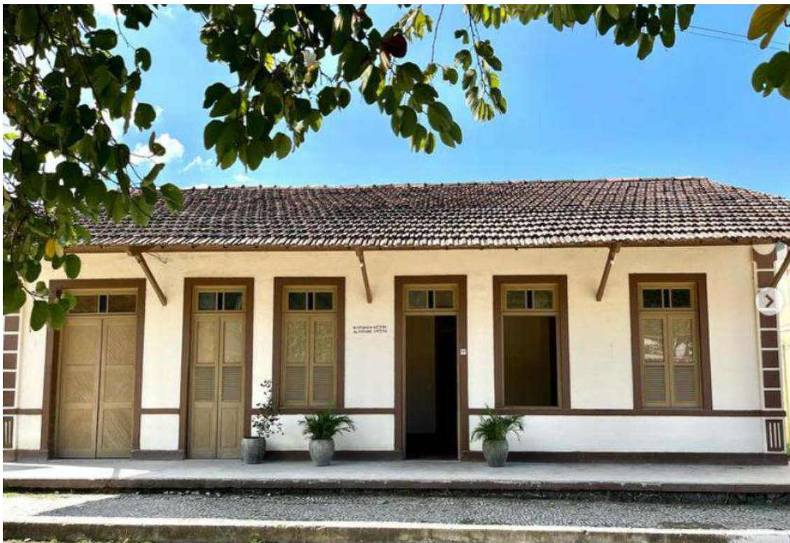
Figura 52: A estação de Tinguá completamente restaurada. Fonte: Foto de Rafael Souza. 2024.
