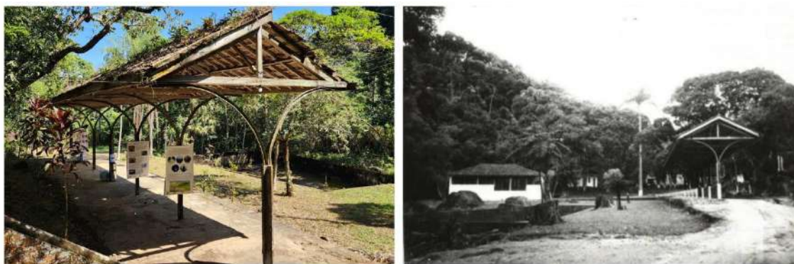
Figura 48: (a) A plataforma da estação Represa durante exposição no local. (Fonte: Foto do autor. Setembro de 2023). (b) Área da antiga estação Represa já sem os trilhos. (Fonte: Acervo INEPAC)
