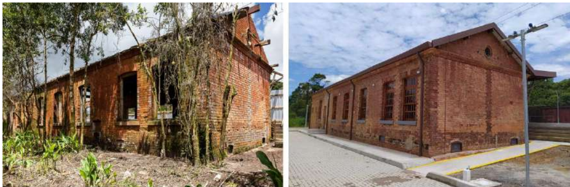
Figura 98: (a e b) A estação antes degradada e completamente restaurada.
