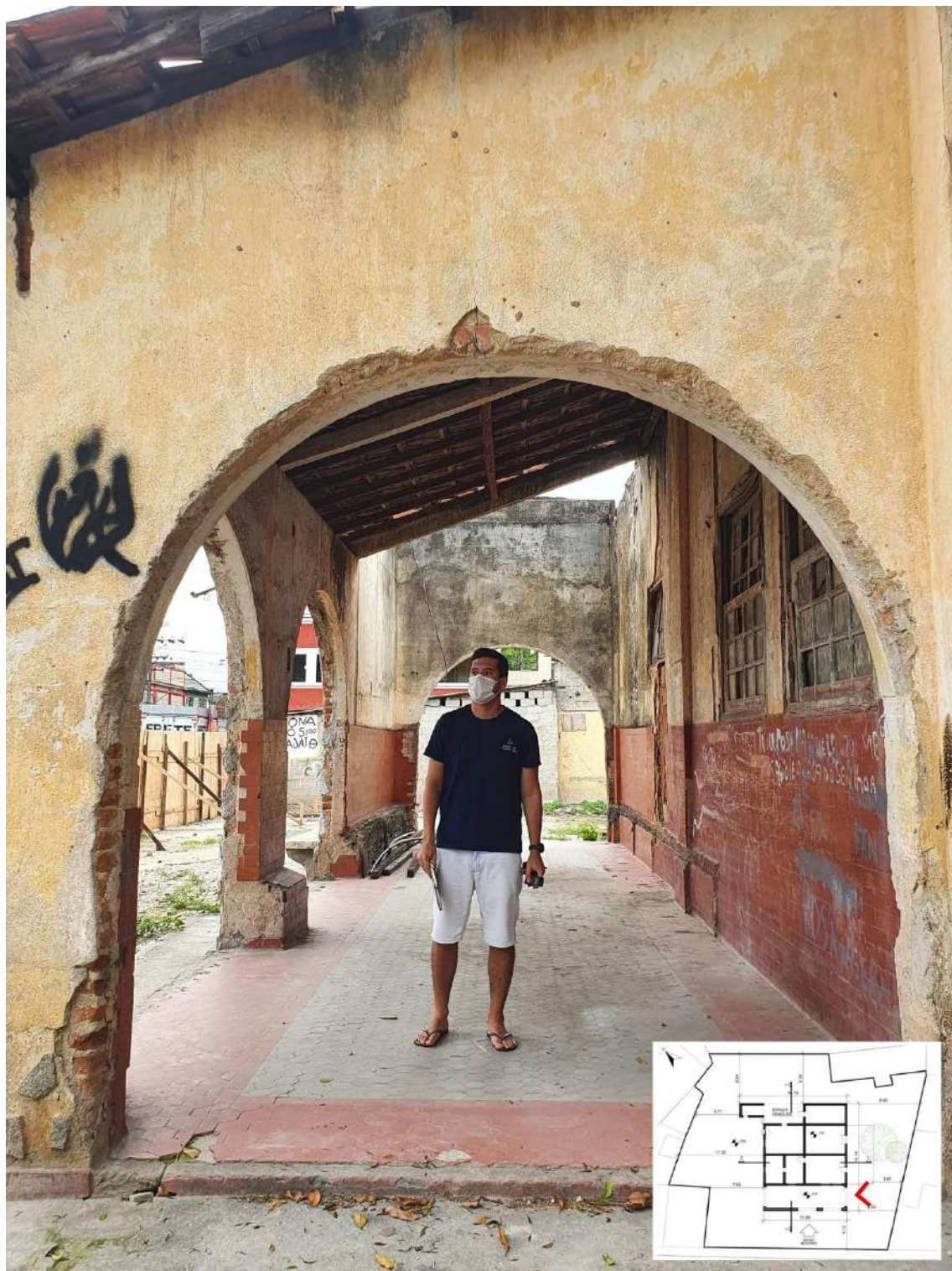
Figura 84: Parte frontal da estação com parte do piso original. Fonte: Foto do autor. setembro de 2021.
