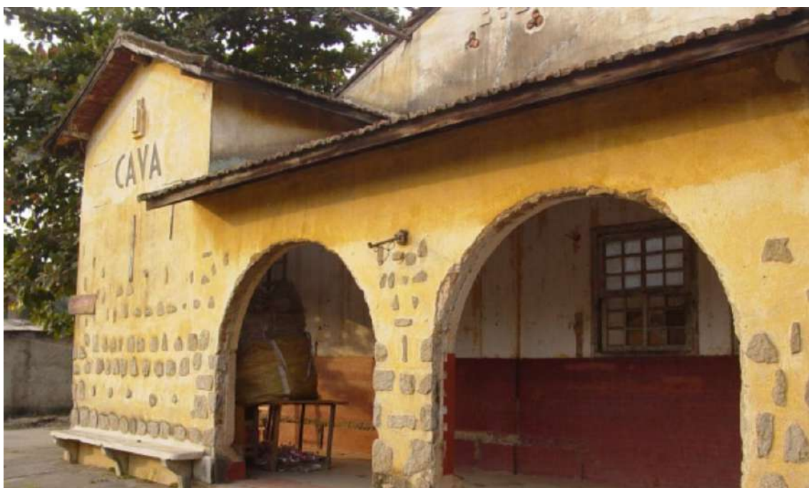
Figura 53: A estação Vila de Cava na década de 1990.
