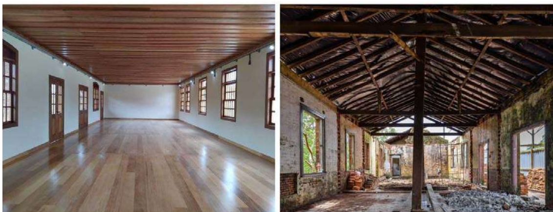
Figura 99: (a) A estação antes degradada e completamente restaurada.
