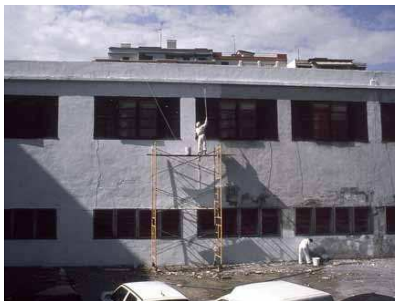
figs. 65 a 68 Gordon Matta-Clark, vista externa, projeto e vistas internas de Day's End (1975). Diserens, Corinne fig. 69 Lara Almárcegui, Restaurando el mercado de Gros unos días antes de su demolición (1995). Ciudades para un mundo más sostenible
