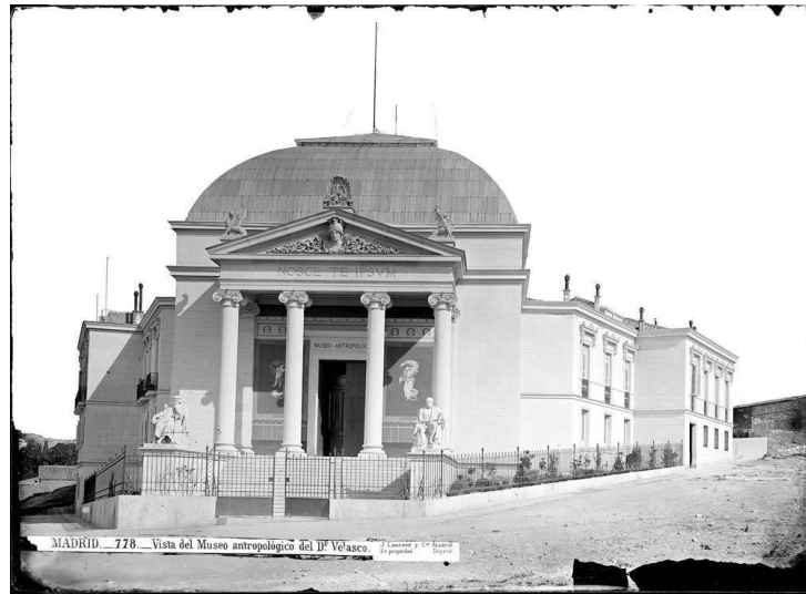
Fotografia 3 - Fachada do MNA entre 1875 e 1886 aproximadamente 43
