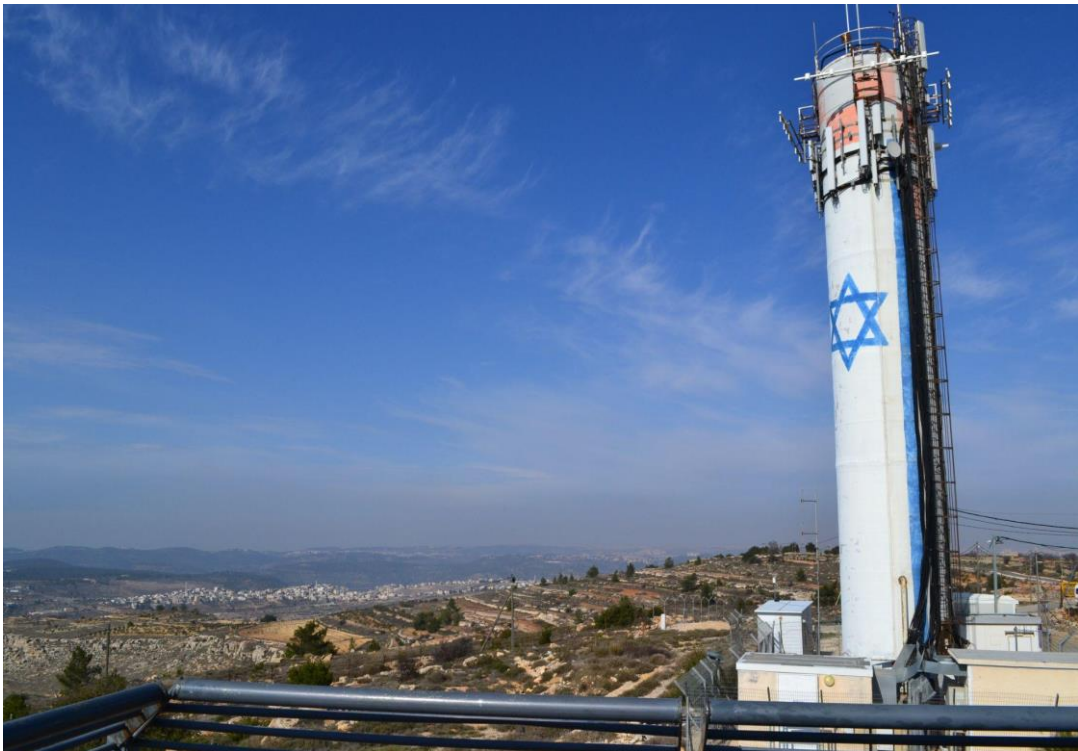
Figura 5- Torre de abastecimento de água em área C da Cisjordânia (2020)
