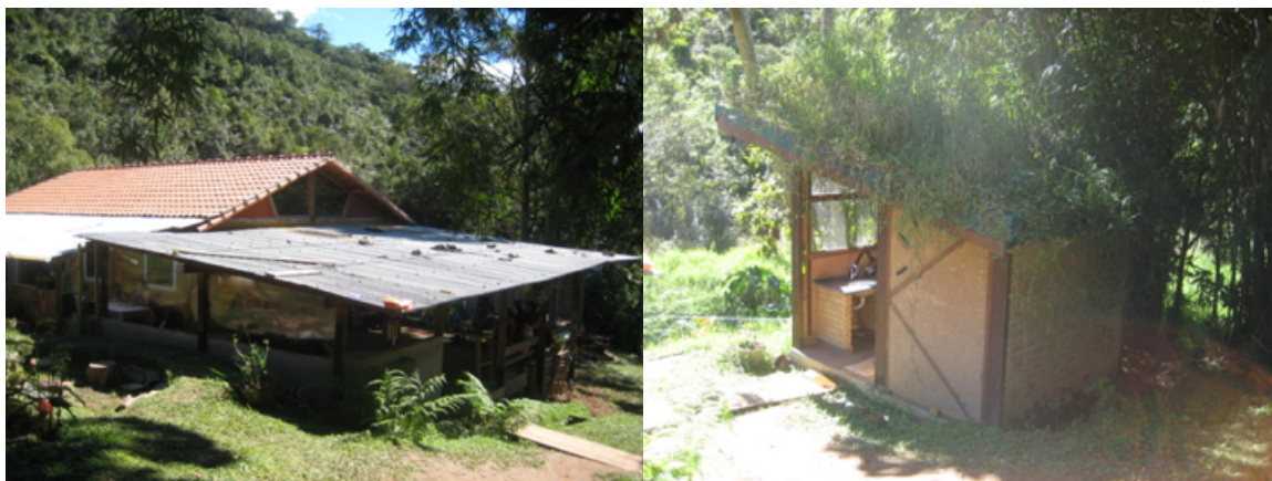
Fotografia 11 – construção comunitária principal/ cozinhas e refeitório / Fotografia 12 – banheiros secos com telhado verde
