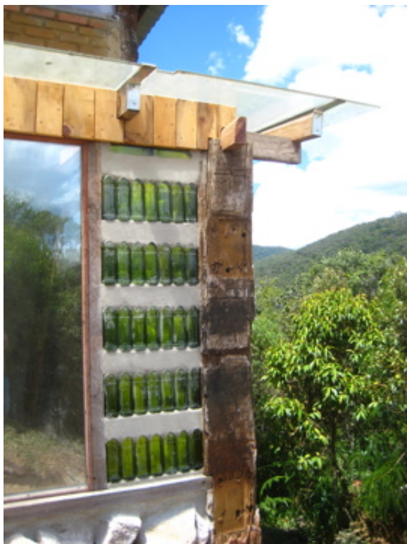
Fotografia 21 – detalhe casa de membro: uso de dormentes de trilho como pilar e de garrafas de azeite na parede.
