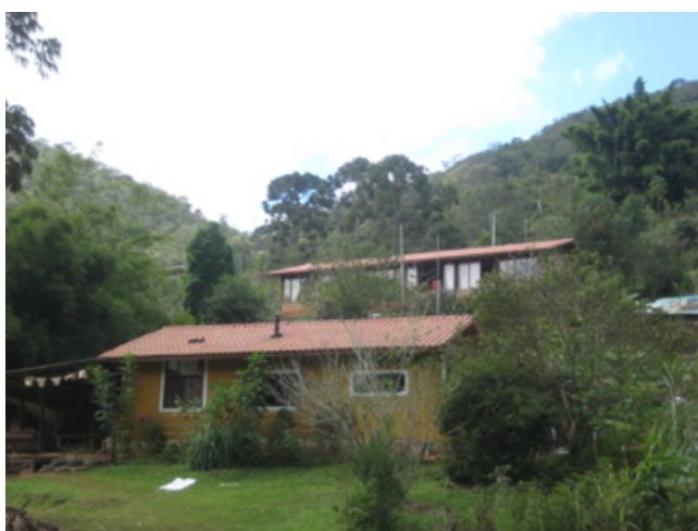
Fotografia 18 – duas construções coletivas: à frente casa com cozinhas e refeitório, ao fundo alojamentos e salão de aulas e vivências.
