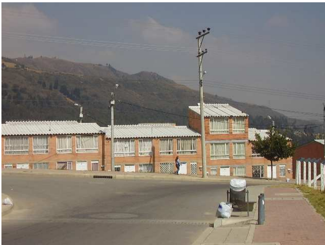
Figura nº 35 – Conjunto Habitacional construído na localidade de USME pela Secretaria de Habitat da Prefeitura de Bogotá:
