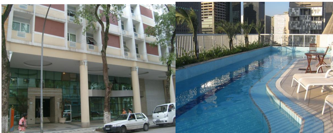
Figura 24 – Vista do edifício Viva Lapa e da área de lazer. [Fonte: http://images01.olx.com.br/ui/19/84/44/1326980892_288768044_2-Fotos-de--Lindo-Flat-no-moderno-Condominio-Viva-Lapa.jpg - data da pesquisa 10.02.2012]
