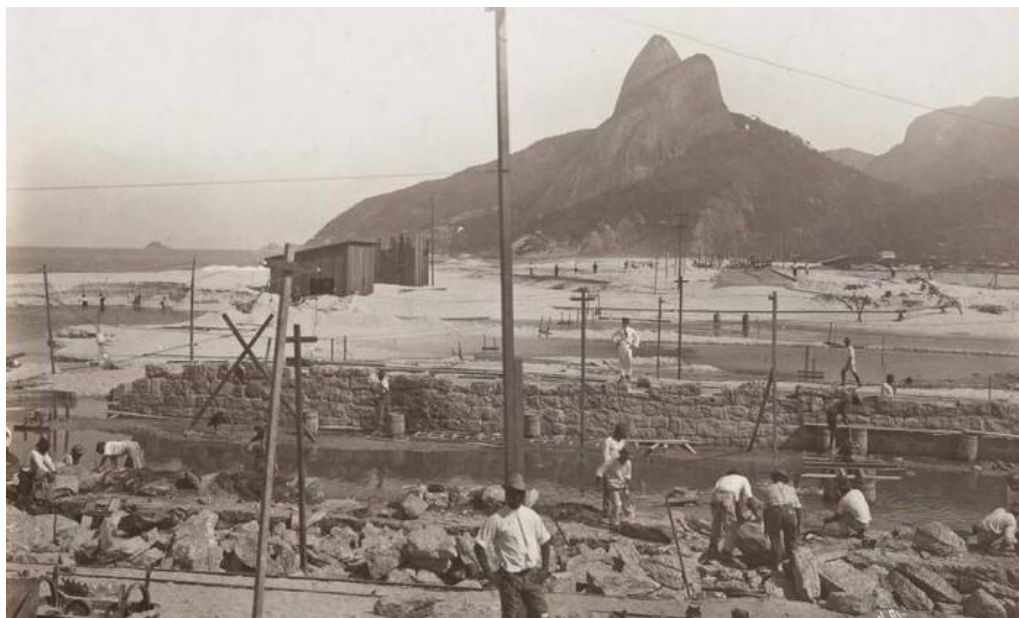
Figura 1 - Construção de ponte sobre o canal Jardim de Alah, que hoje separa os bairros de Ipanema e Leblon
