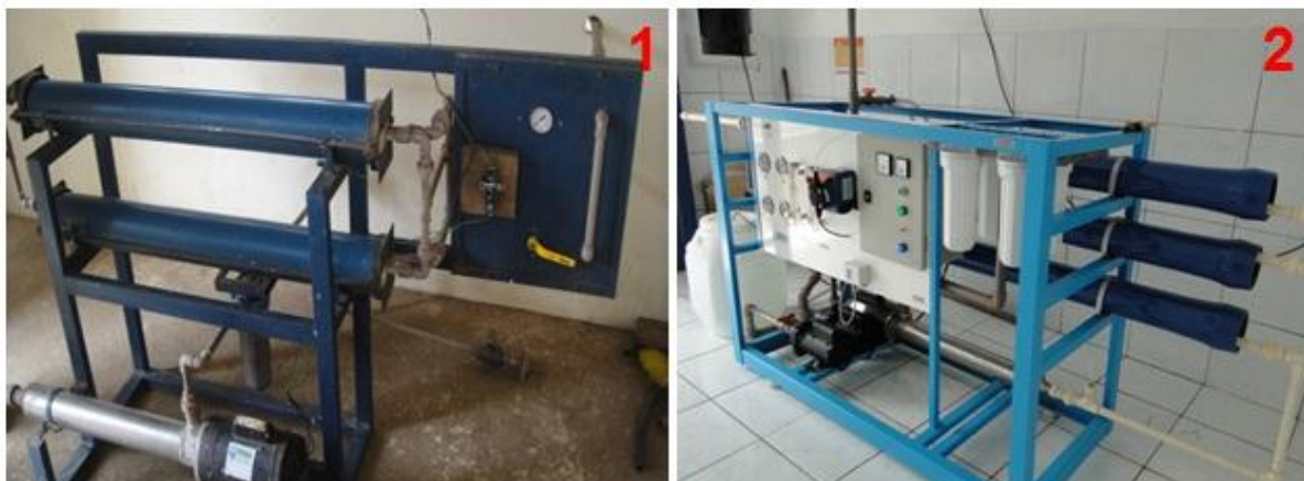
Figura 15 – Dessalinizadores instalados em 1997 (1) e 2011 (2) no Assentamento Cachoeira Grande - Aroeiras/PB.
