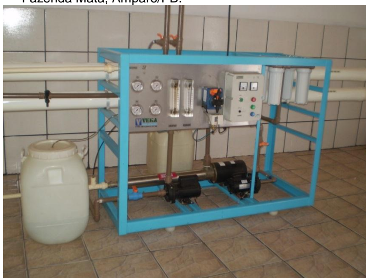
Figura 8 – Dessalinizador usado pelo PAD, Assentamento Fazenda Mata, Amparo/PB.
