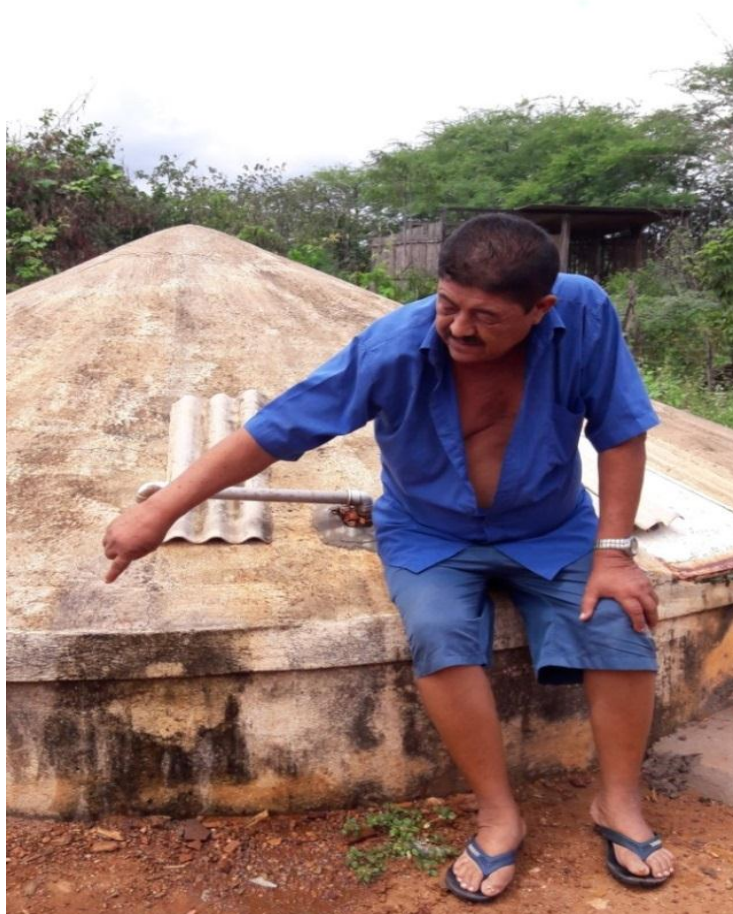
Figura 18 – Beneficiário mostra o vazamento da cisterna Malhada da Quixaba - Amparo/PB.
