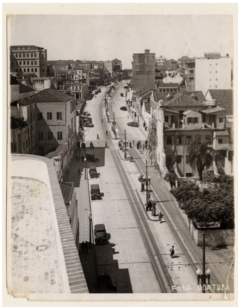
Figura 4 – Avenida Borges de Medeiros, trecho do ramo norte: ainda em execução durante a década de 1930, faltando desapropriar imóveis junto à rua dos Andradas (canto inferior direito). Este trecho, especialmente na parte alta, junto ao viaduto que já estava concluído, teria o “grave defeito” aludido pelo intendente Montauray em 1927, o qual teria motivado a alteração do traçado da avenida.
