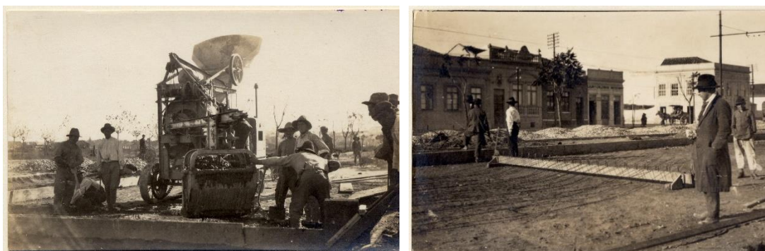
Figura 29 – Obras de pavimentação de concreto na avenida Bom Fim (atual Oswaldo Aranha), em 1927.
