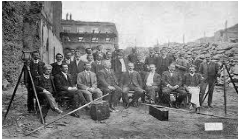
Figura 13 - Avenida Central - Comissão Construtora – 1905 - Rio de Janeiro
