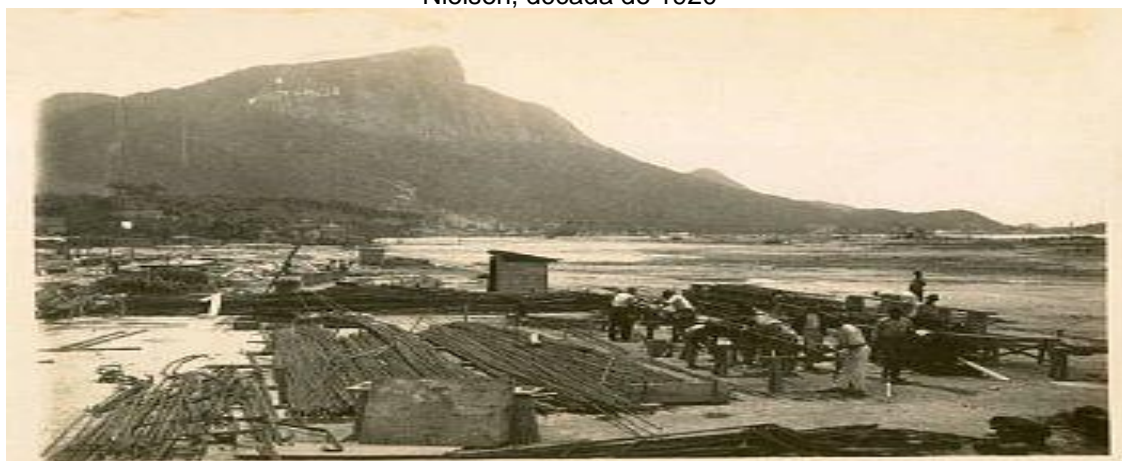
Figura 21 - Jóquei Clube do Rio de Janeiro ainda em construção – construtora Christiani Nielsen, década de 1920
