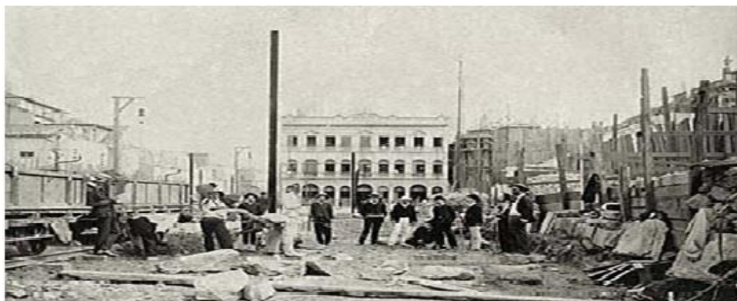
Figura 10 - Demolições para a construção da Avenida Central - 1904-1905
