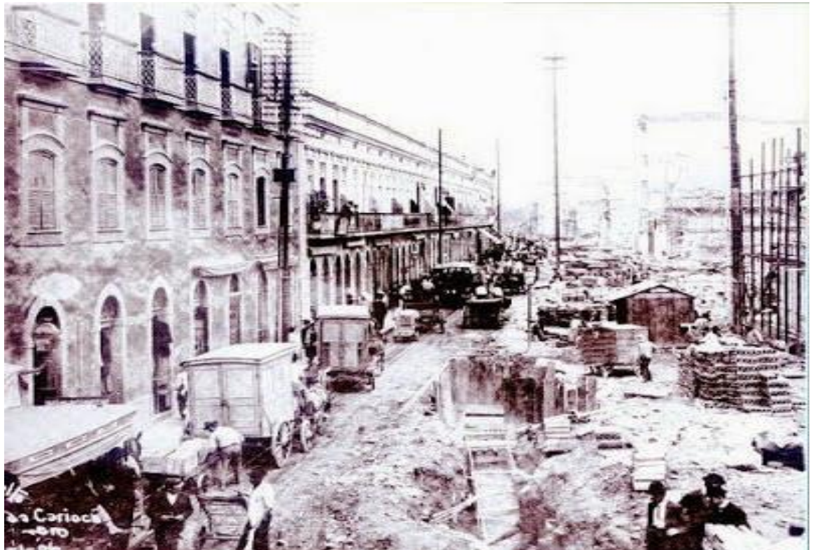
Figura 5 - Centro da cidade do Rio de Janeiro vira um canteiro de obras – início do Século XX
