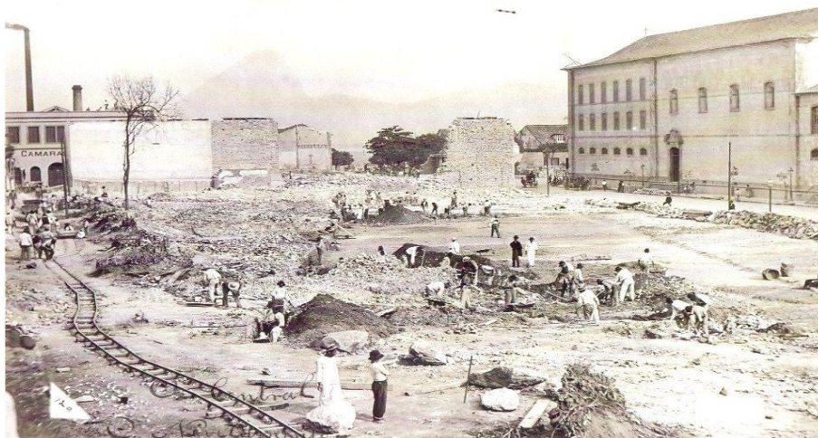
Figura 14 - Primeiros momentos da construção da Avenida Central - 1905
