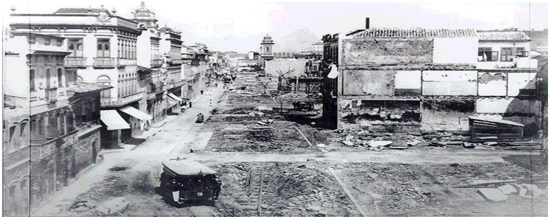
Figura 6 - Demolições no centro do Rio de Janeiro – início do Século XX
