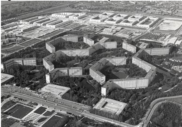
Figura 13: Foto aérea Bairro Bijlmermeer antes da reabilitação
