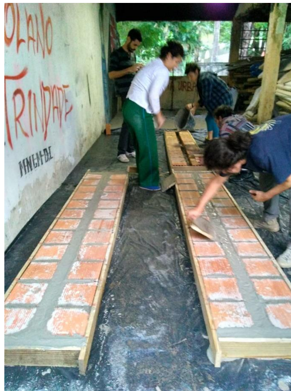
Figura 24 - Preenchimento com argamassa
