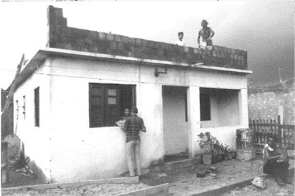
Figura 9 - Casa já habitada, em término de construção
