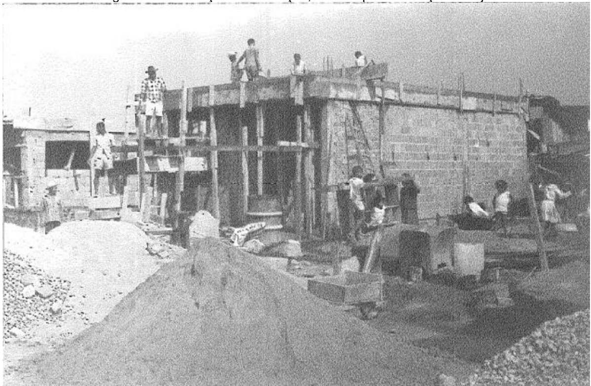
Figura 8 - Construção da habitação, mutirão para execução da laje
