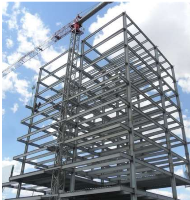
Figura 5: Exemplo de edifício construído em estrutura metálica: sistema construtivo menos habitual.
