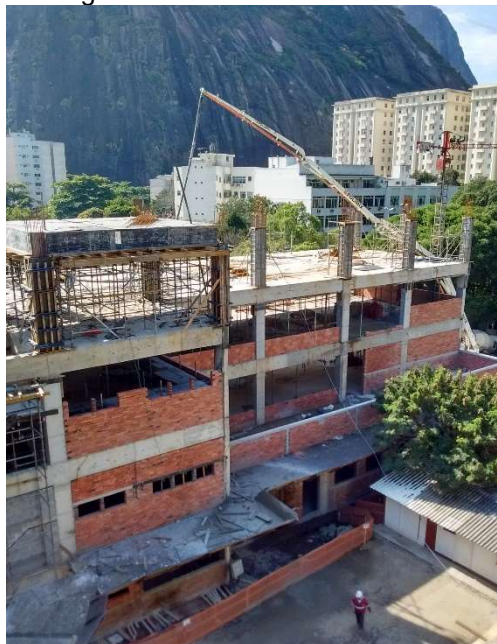
Figura 4: Obra do CCH/UNIRIO construída com estruturas de concreto armado e alvenaria convencional: imagem clássica de obra no Brasil.
