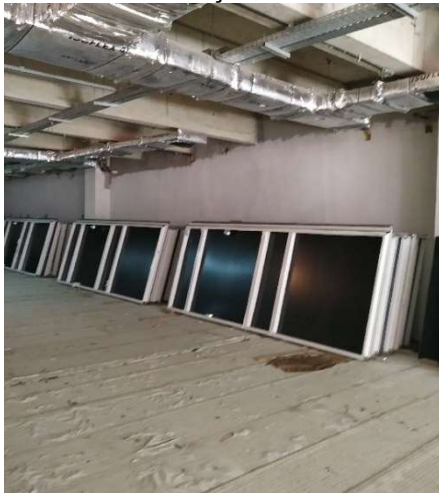
Figura 15: Estoque de esquadrias com vidros no canteiro aguardando a instalação final.
