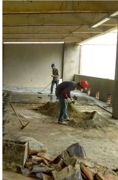
Figura 7: Ajudante “virando” argamassa manualmente sobre a laje para assentar piso.
