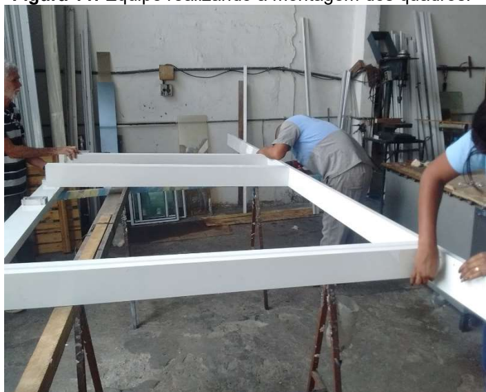
Figura 11: Equipe realizando a montagem dos quadros.
