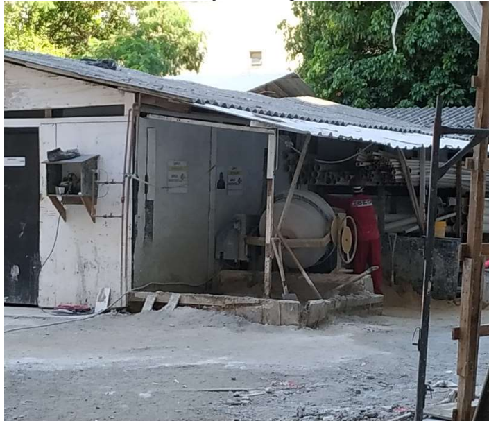
Figura 6: A betoneira junto ao pátio, que em tese centraliza toda a fabricação de argamassas no canteiro.
