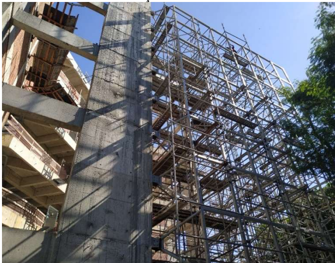
Figura 17: Montagem final dos módulos pré-fabricados da treliça no canteiro.
