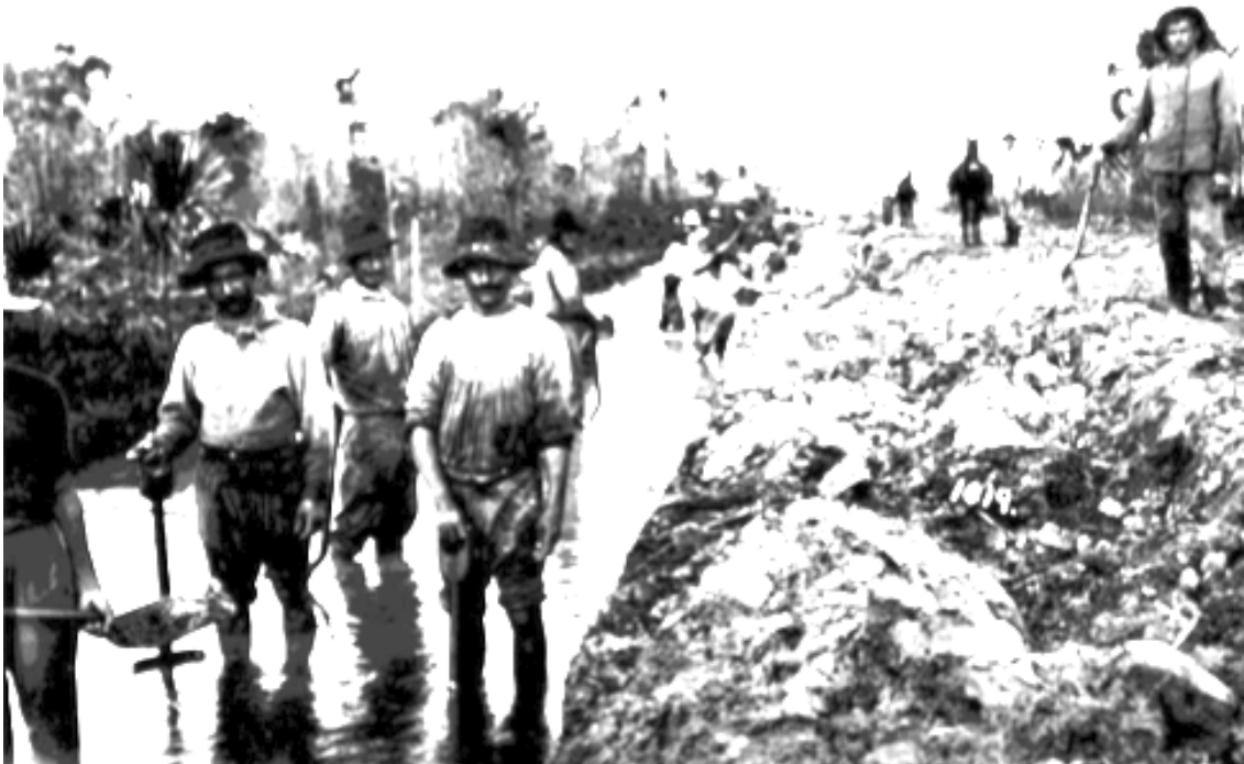
Fotografia 8: Trabalhadores na construção EFMM
