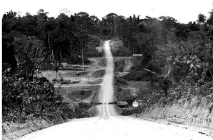
Fotografia 15: Trecho da Rodovia Transamazônica
