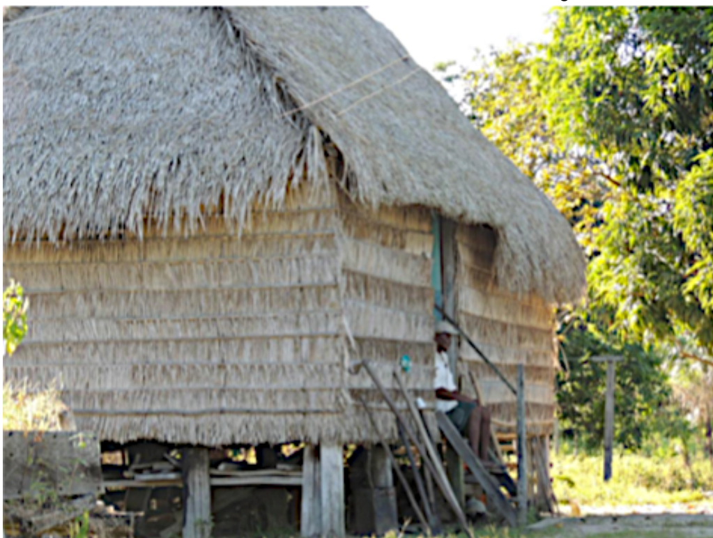
Fotografia 25: Quilombo de Santo Antônio do Guaporé - RE/RO. Residência do senhor Stefânio, um dos moradores vivos, mais antigos da comunidade
