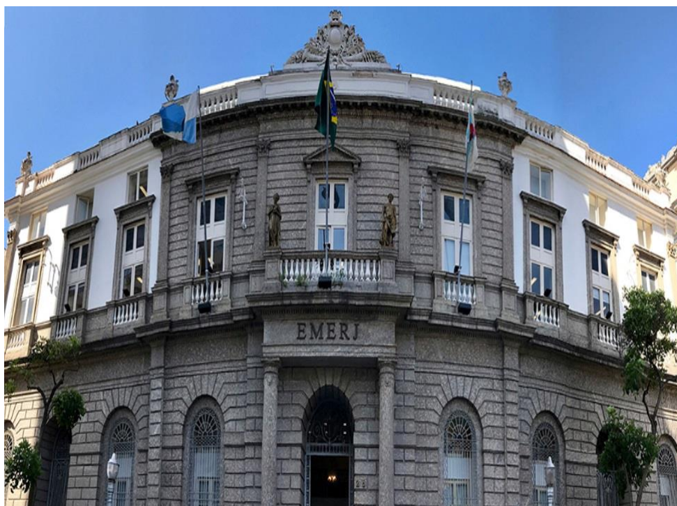
Figura 02. Faixada do prédio EMERJ: ASAS; Centro do Rio de Janeiro.
