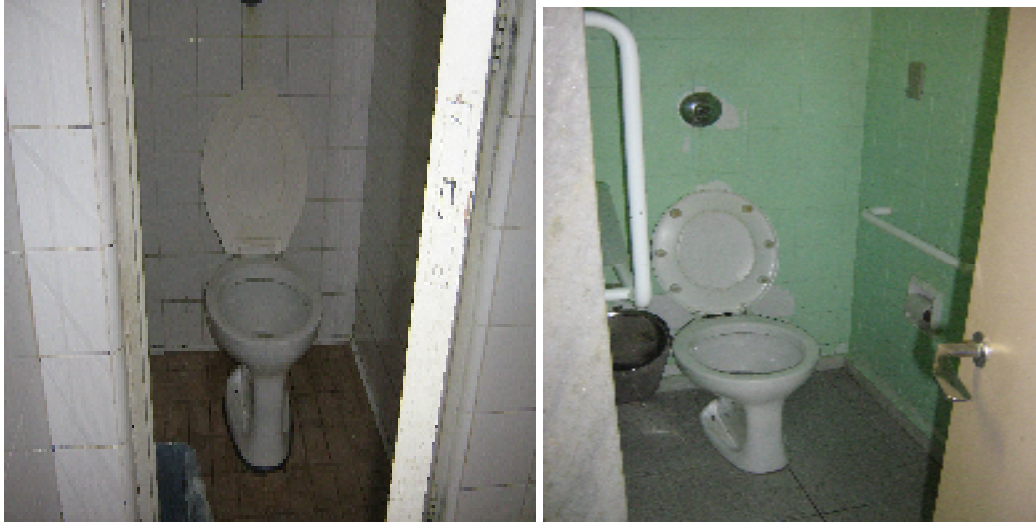
Ilustração 2- Banheiro do setor 9C (esq.) e banheiro do setor 9D (dir.)
