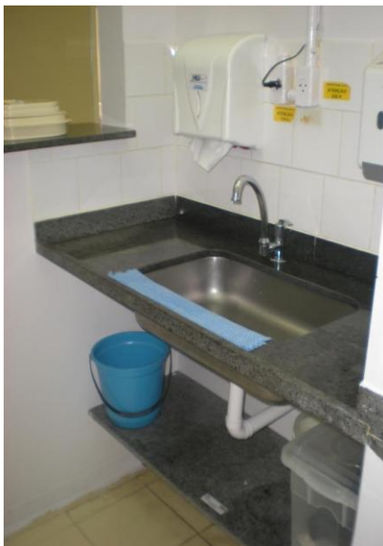
Foto 15 - Sala de expurgo
