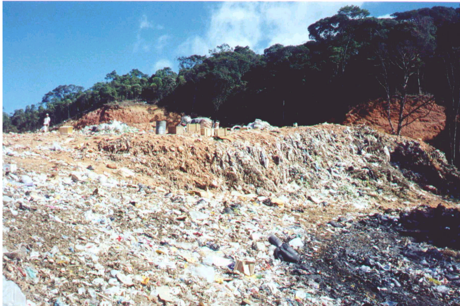
Foto 2.1 - Talude sub-vertical no vazadouro de lixo da rua Duarte da Silveira, em Petrópolis.
