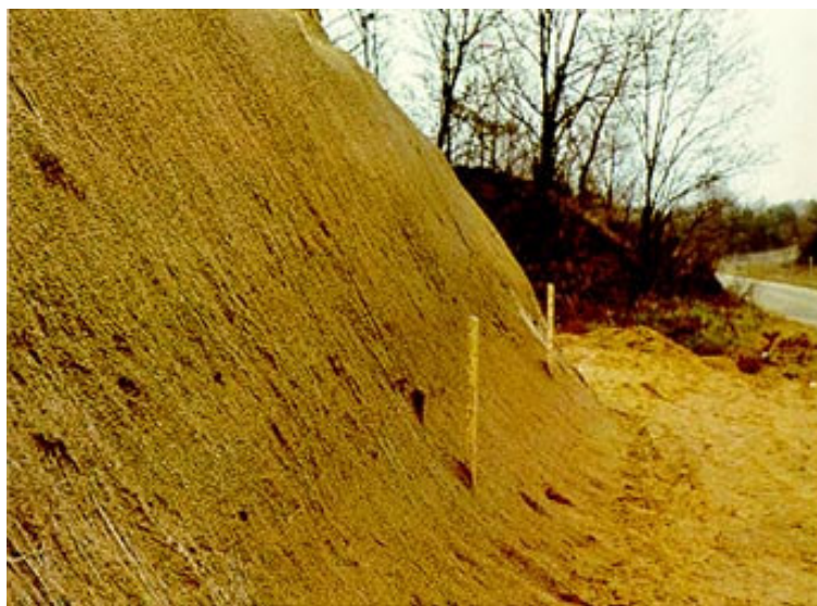
Foto 3.1 - Talude de solo reforçado – Sistema Texsol (Texsol, 2002)
