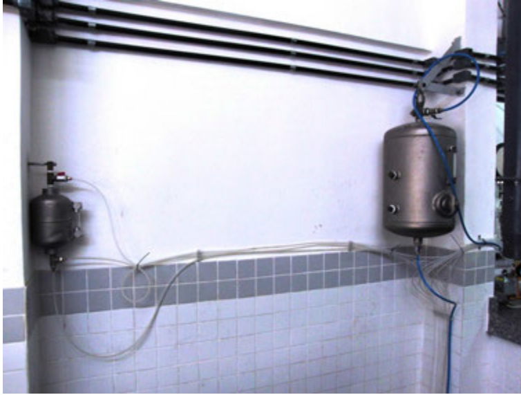
Figura 3.19 – Reservatório de ar e água lateral (à esquerda) e vertical (à direita).
