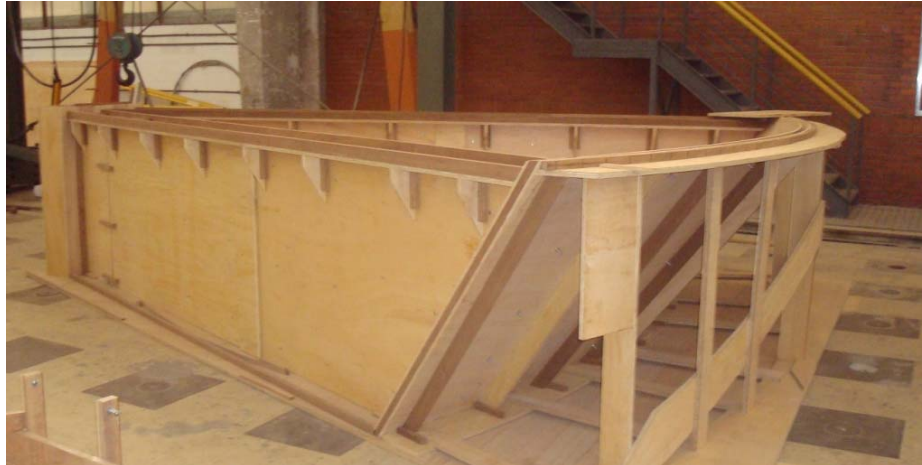
Figura 8.17 – Vista da forma de madeira do protótipo de um setor do flutuador acabada.
