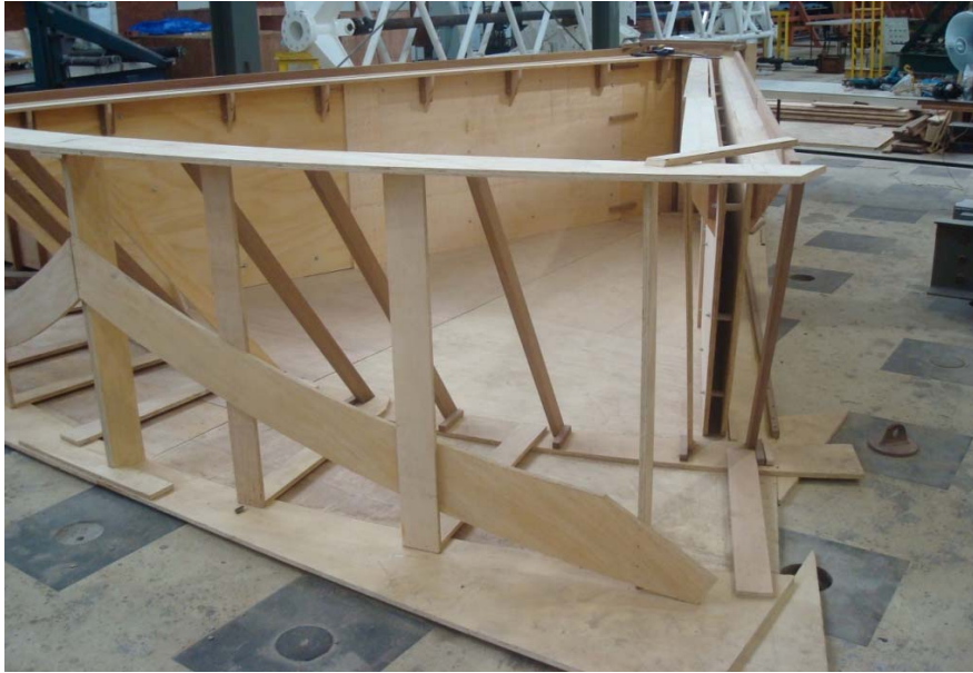
Figura 8.15 – Detalhe de montagem das nervuras laterais da forma do flutuador.
