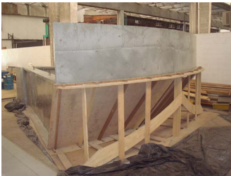
Figura 8.22 – Detalhe da forma parcialmente retirada.
