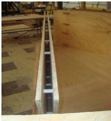
Figura 8.16 – Detalhe dos espaçadores na alma das nervuras.
