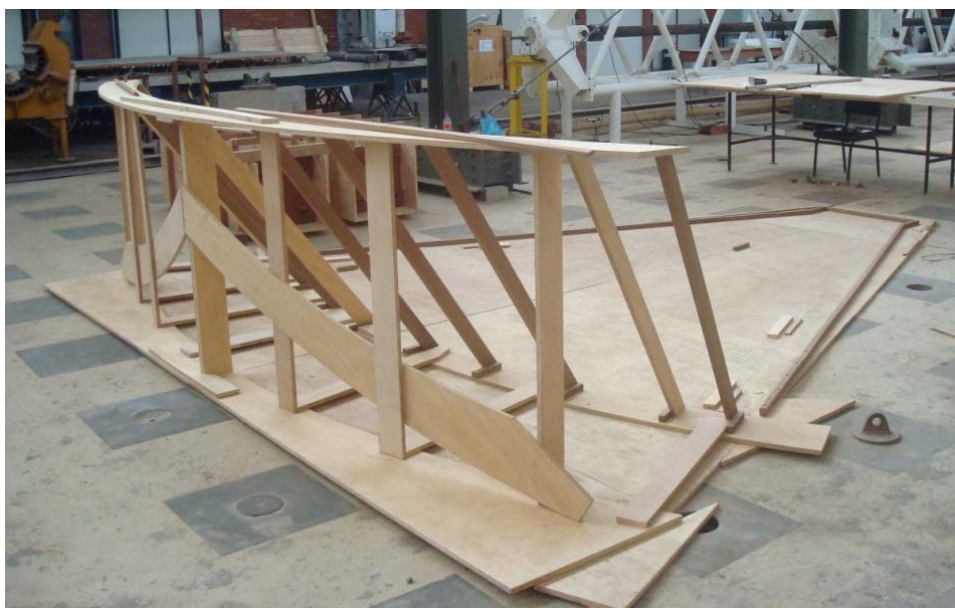
Figura 8.14 – Montagem do fundo e da parede externa arqueada e inclinada da forma.
