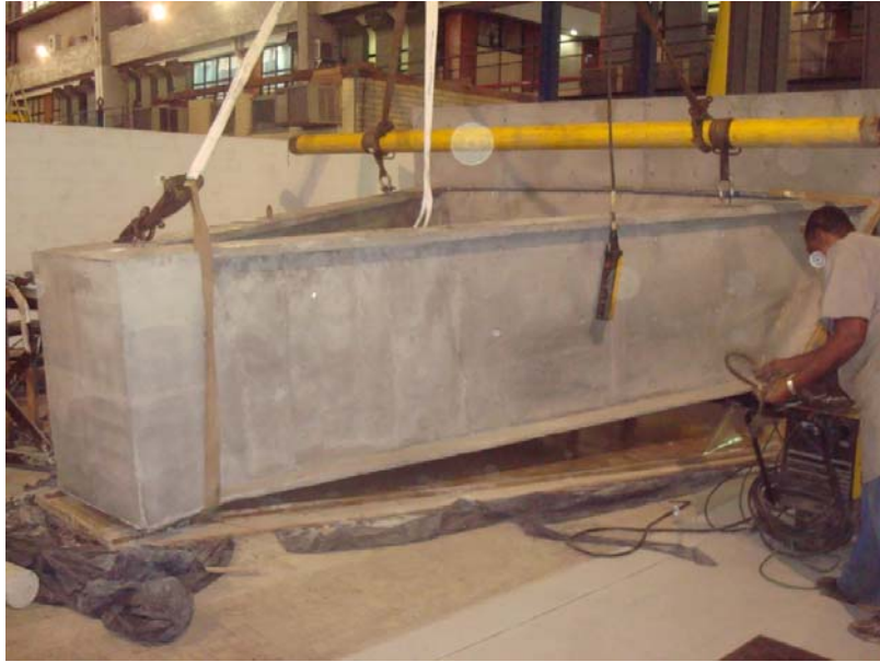
Figura 8.23 – Início do içamento do protótipo para desforma final.
