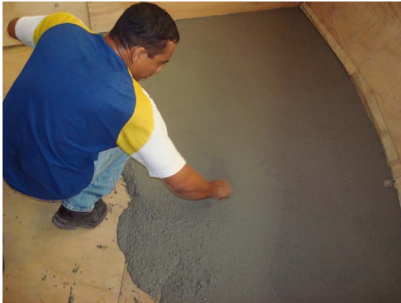
Figura 8.20 – Concretagem do fundo da forma do protótipo.
