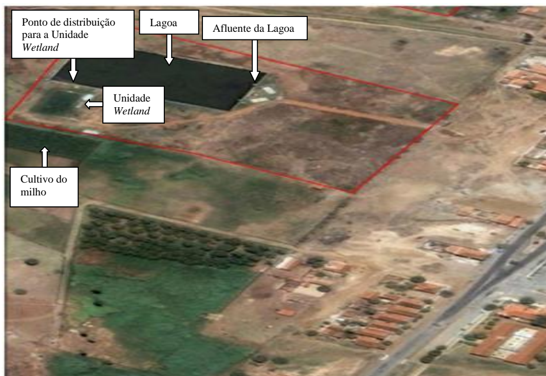
Figura 4.5 - Imagem da situação da ETE B4 e da Unidade Wetland (2).
