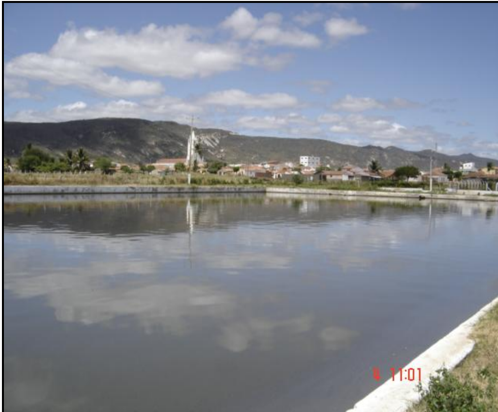
Figura 3.5 – Foto da Lagoa Facultativa Primária da ETE em Parelhas/RN (2005). Fonte: Arquivo pessoal (2005)
