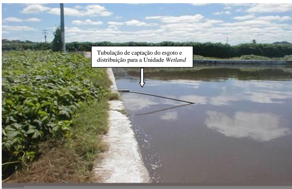
Figura 3.10 – Foto da Tubulação de Captação do Afluente da Unidade Wetland. Fonte: Arquivo pessoal (2005).
