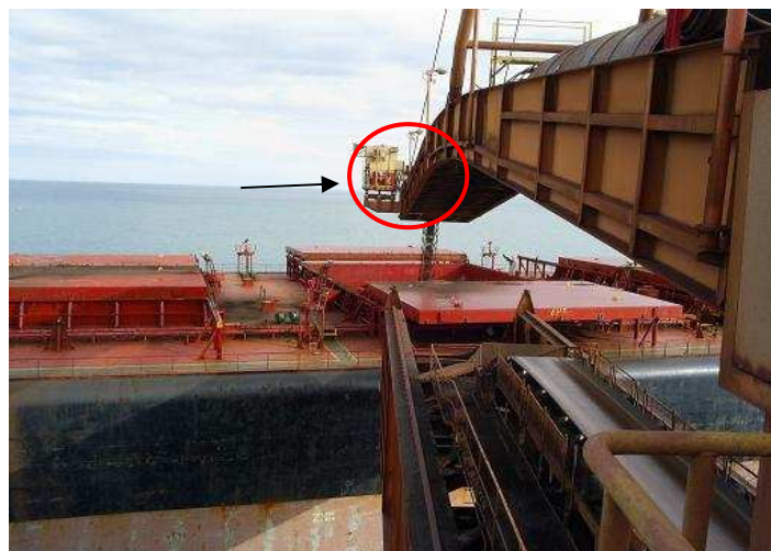
Figura 5.5 : Cabine do operador
