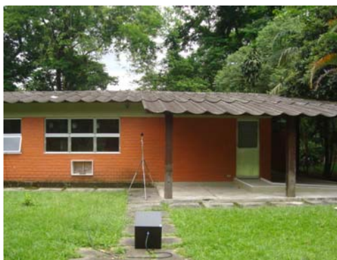
Figura 6.37 - Vista externa da fachada medida da edificação, local 4.
