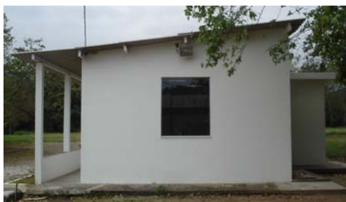
Figura 6.34 - Vista externa da fachada medida da edificação, local 1.
