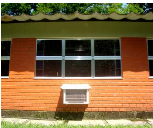
Figura 6.35 - Vista externa da fachada medida da edificação, local 2.
