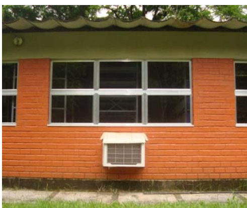
Figura 6.36 - Vista externa da fachada medida da edificação, local 3.
