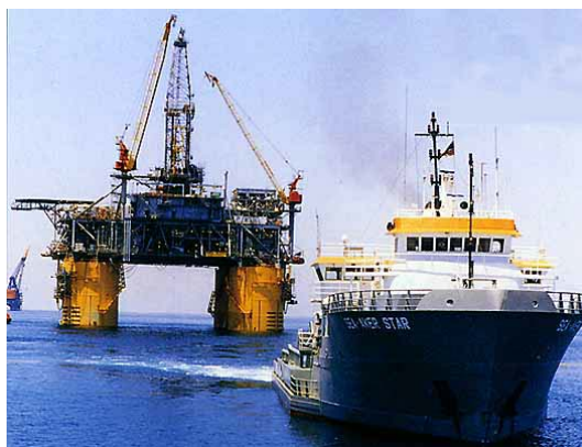
Figura 2.4 – TLP Ram Powell (Shell) – Profundidade 1100 metros
