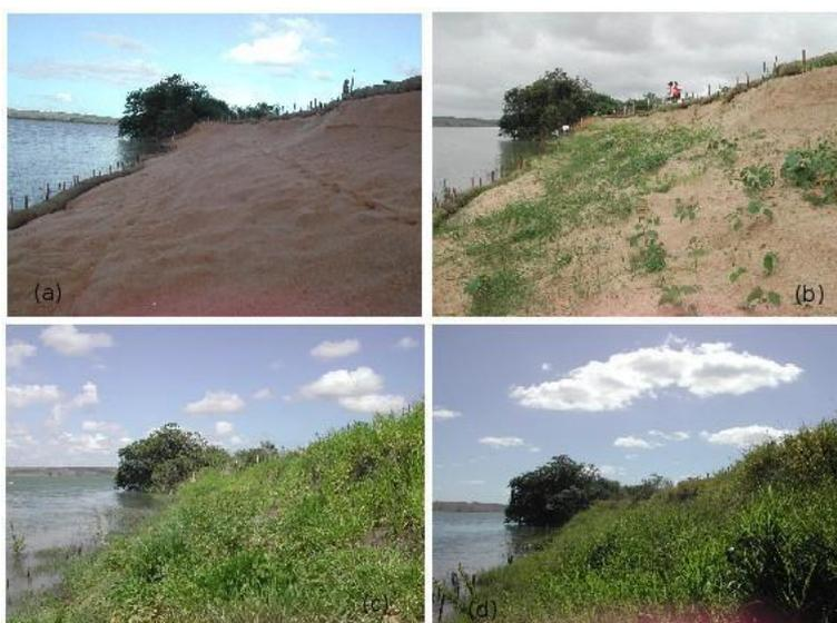
**Figura 55.** Quatro momentos distintos: (a) a área recoberta pelo geotêxtil e, na base do talude, instalados retentores de sedimentos; (b) em agosto de 2004 ocorreu o desenvolvimento das espécies plantadas; (c) após três meses, a área totalmente povoada e conseqüentemente o processo erosivo controlado; e (d) em janeiro de 2005 a vegetação densa protege o talude antes erodido (RIBEIRO, 2008).
