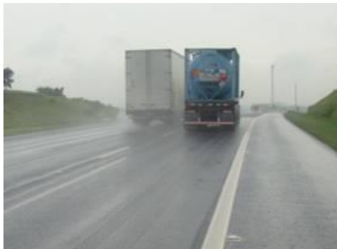
Figura 14: Efeito do borrfifo de água ( spray ) em local sem SMA.
