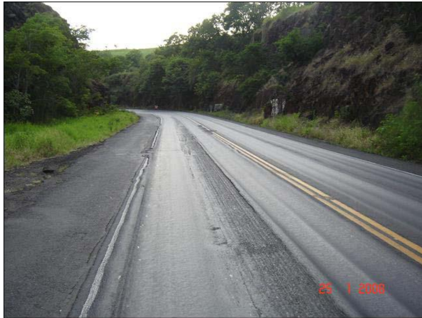
Figura 55: Afundamento de Trilha de Roda (NASCIMENTO, 2008).
