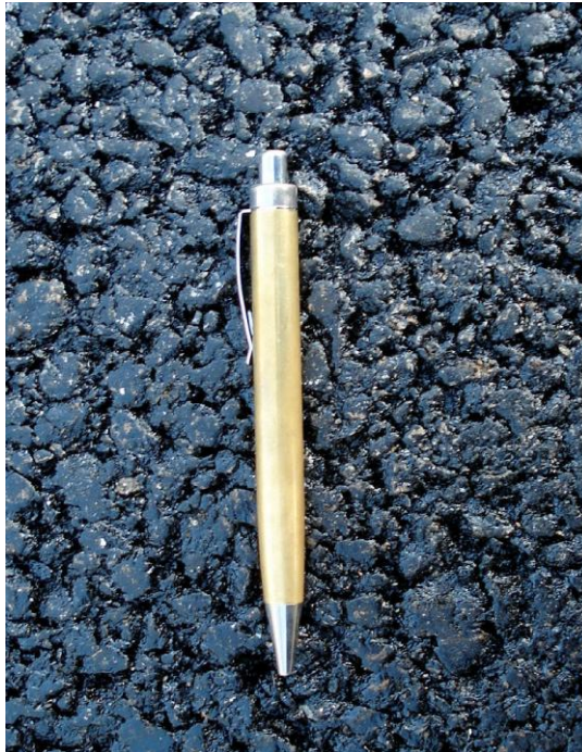
Figura 11: Visão da textura de um revestimento asfáltico com SMA ( www.der.pr.gov.br/arquivos - consulta 23/2/2011).
