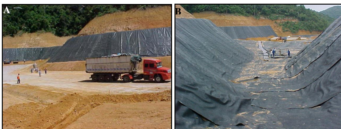
Figura 3.5: A- Vista da área de descarga com dupla camada de impermeabilização de base. B- Impermeabilização de base – manta de PEAD (OLIVEIRA, 2004b).
