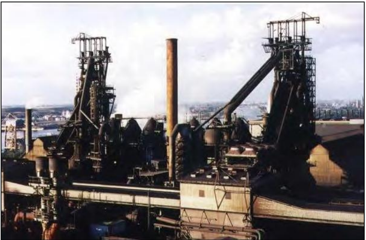
Figura 2.30 Vista geral de dois altos fornos, com três regeneradores cada, com as respectivas chaminés para os gases de combustão provenientes dos regeneradores (IPCC, 2010).
