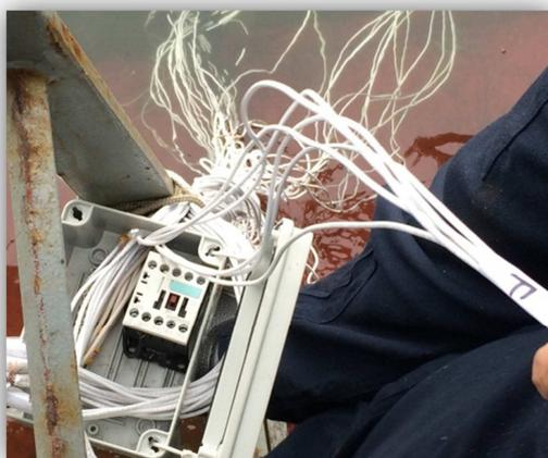
Figura 52 – Caixa de junção selada para medição de potencial.
