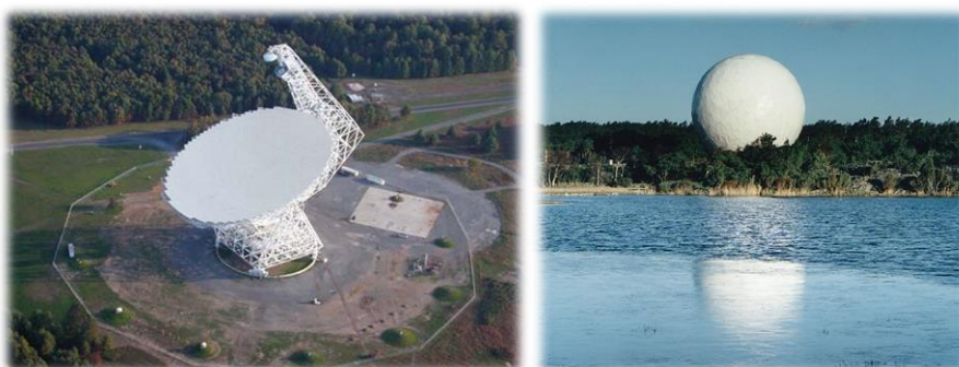
Figura 9. Radiotelescópio, à esquerda. Radomes – i.e. estrutura protetiva de radiotelescópios a intempéries, à direita. Fonte: BRITANNICA ACADEMIC, 2020
