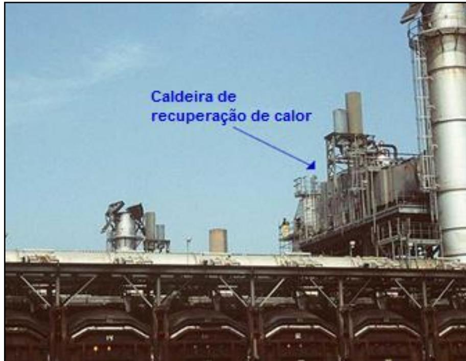
**Figura 45. Coqueria com caldeira para recuperação de calor (Fonte: American Iron and Steel Institute, 2012).**
