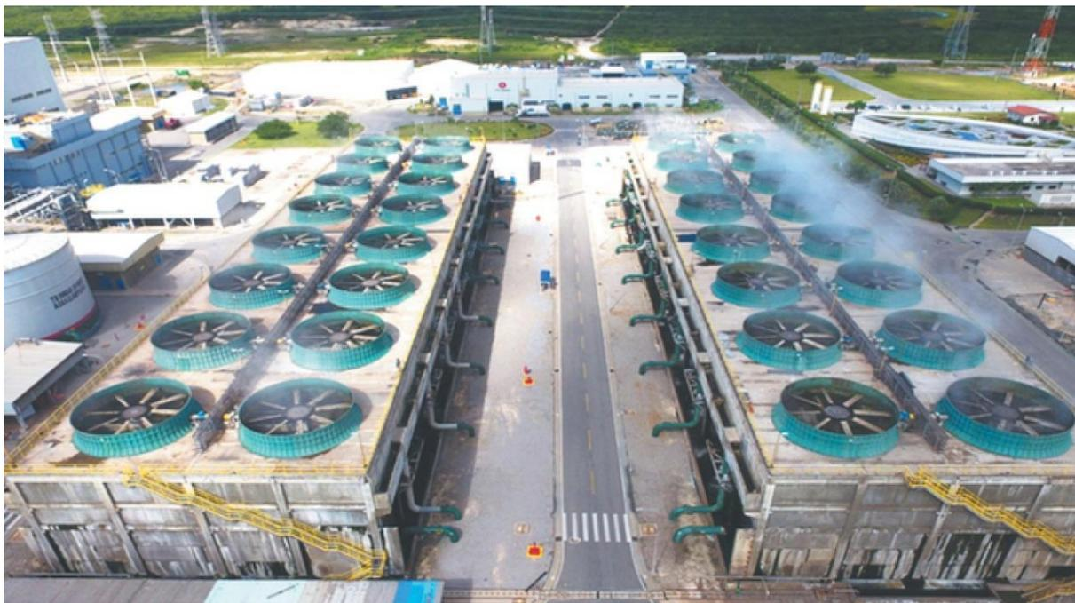
Figura 4: Imagem do funcionamento de torres de resfriamento abertas com recirculação. Fonte: Acervo Pecém, 2020.
