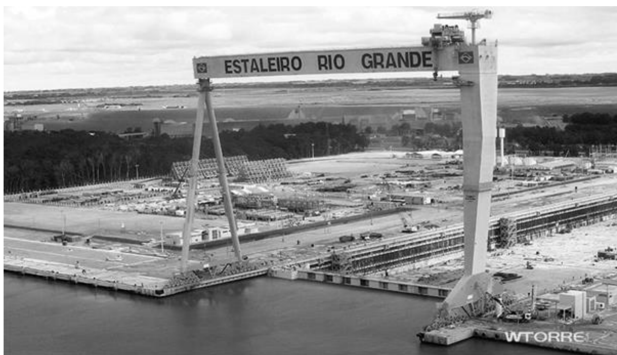
Figura 34 – Fotografia aérea do Dique Seco. É o maior da América Latina, com 133 metros de largura por 350 metros de comprimento e 13,8 metros de profundidade. Fonte: http://www.wtorre.com.br/projetos/estaleiro-rio-grande/246 acessado em 13 de julho de 2015.
