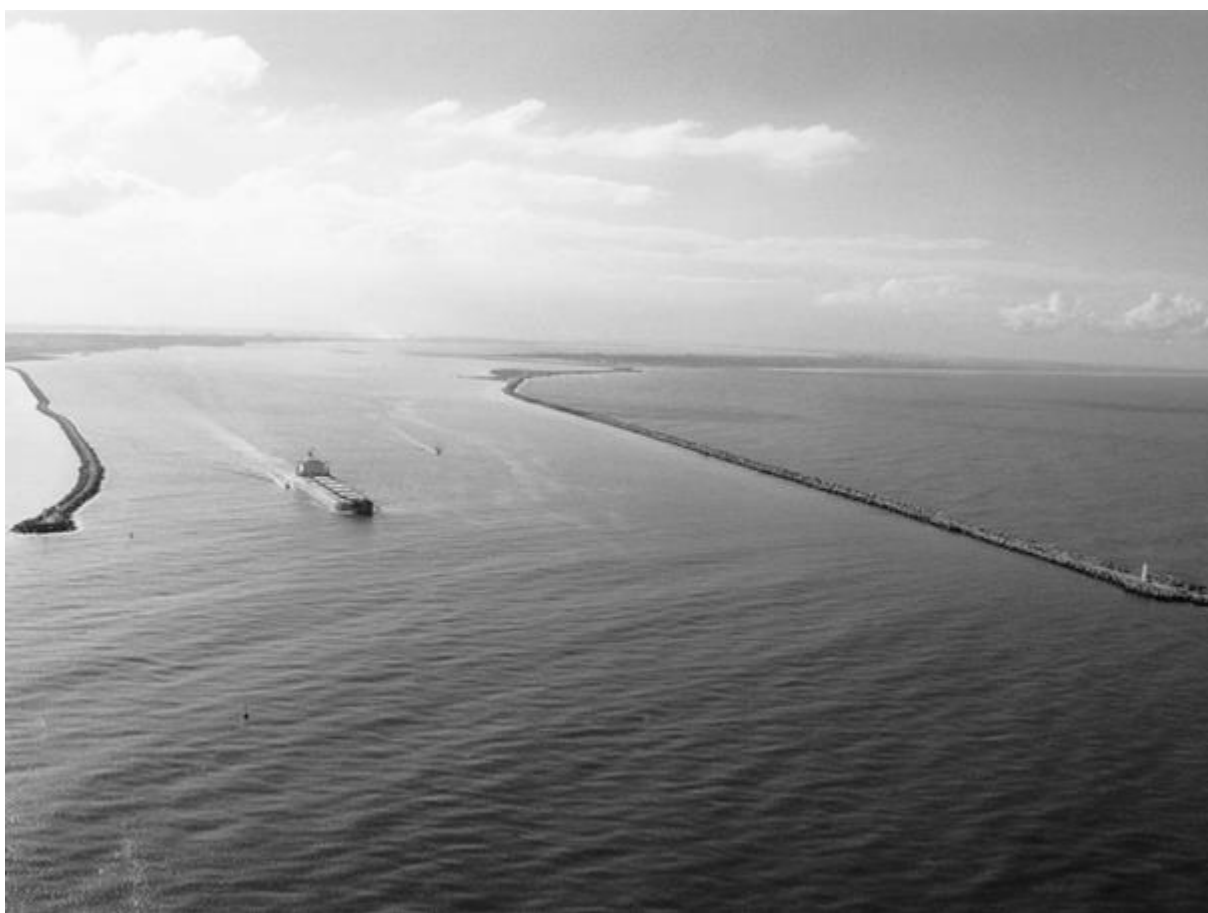
Figura 28 – Os molhes de pedra que formam a entrada da Barra do Rio Grande. Fotografia tirada antes da ampliação realizada no século XXI. Fonte: http://www.portoriogrande.com.br/site/imprensa_midia_galerias.php acessado em 13 de julho de 2015.
