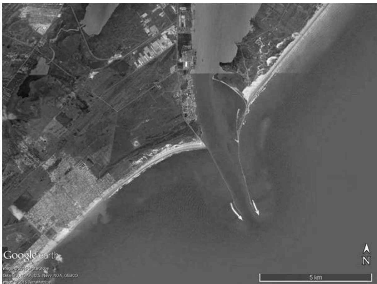
Figura 29 – Os gigantes Molhes da Barra do Rio Grande. As setas indicam o trecho ampliado cuja conclusão se deu em 2014. Fonte: Google Earth. Editado.
