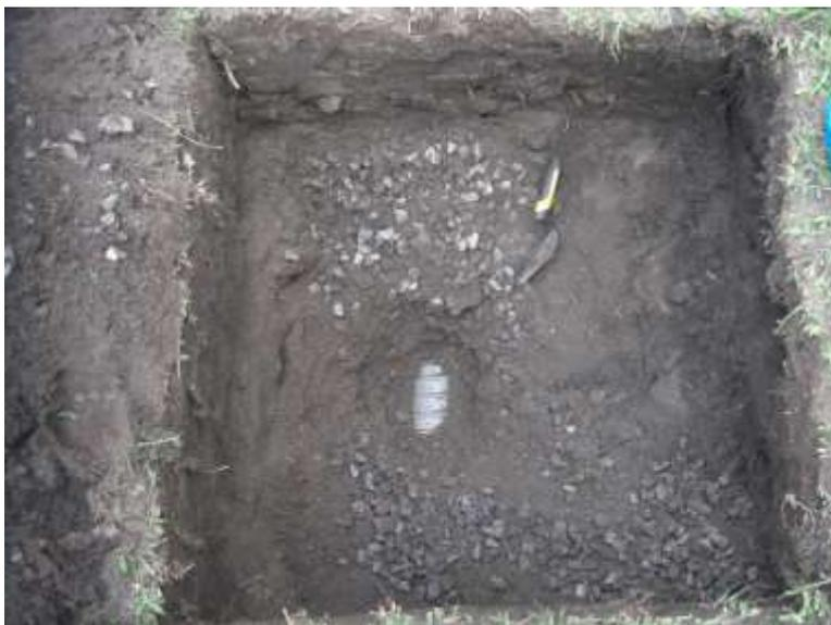
Figura 69: Camada de pedras brita e tubulação de drenagem do solo em aproximadamente 75 cm de profundidade, S5. Lucia Brito, 2022.
