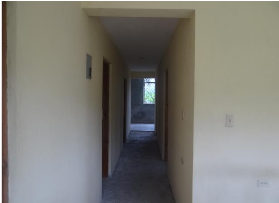
Foto 43: O corredor que divide pelo meio as peças do segundo andar da casa do primo do Jerome. Crédito meu, julho de 2013.
