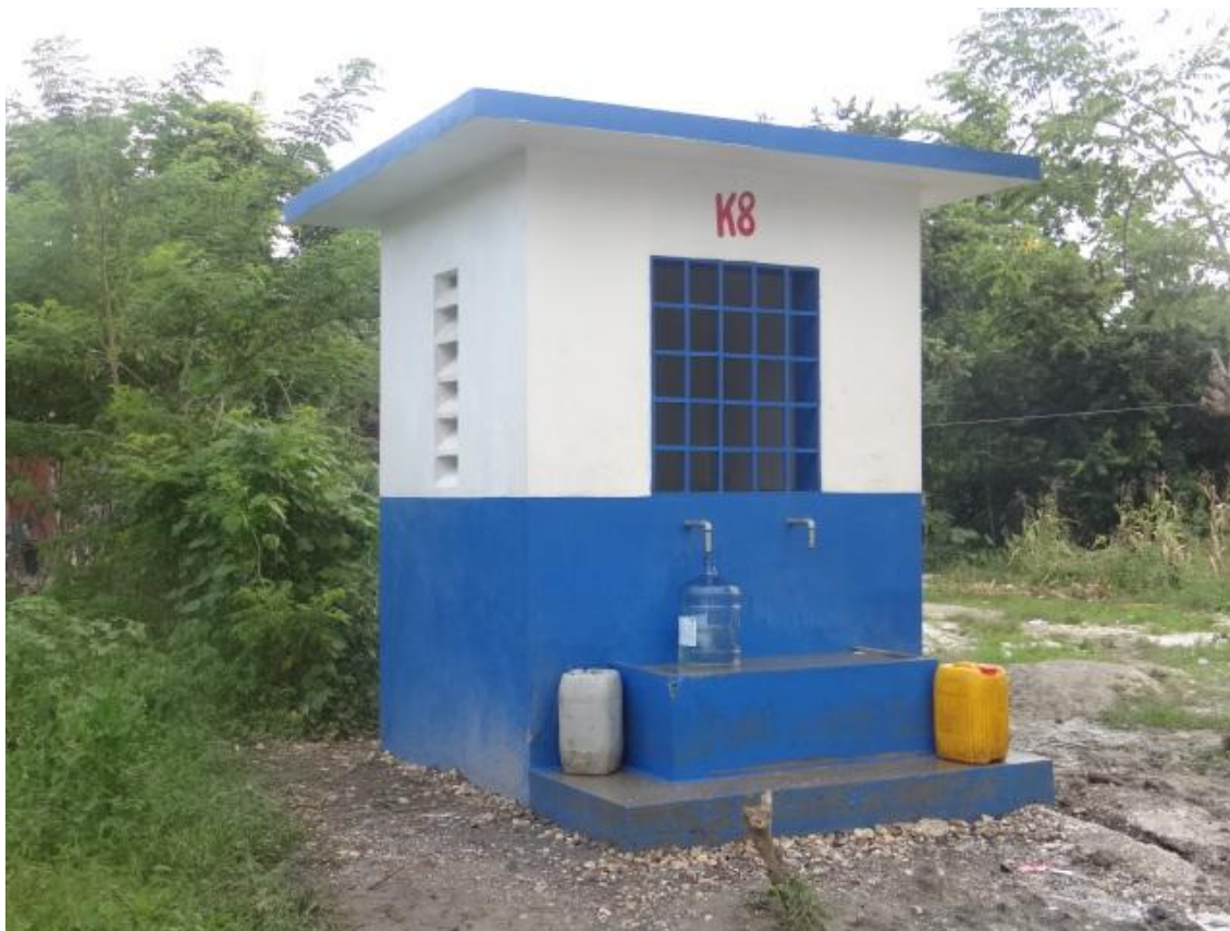
Foto 35: Pomp dlo em Fonds-des-Nègres. Crédito meu, julho de 2013.
