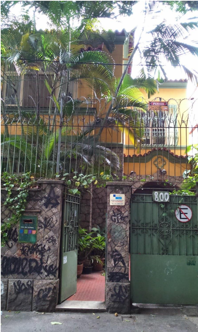
Fig. 6 Entrada da Casa das Palmeiras, em Botafogo.
