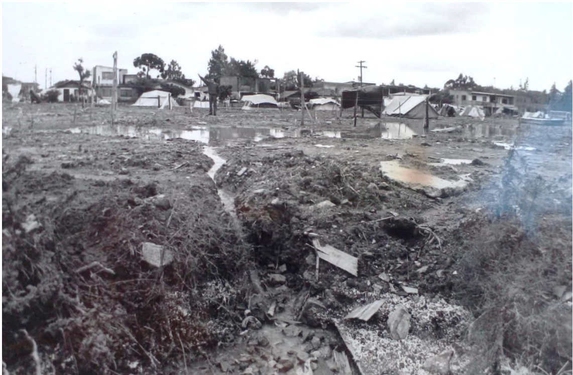
Imagem 10: Barracas ocupando o terreno, após a terraplanagem. Reprodução da foto retirada em 1993. Fotógrafo Vilmar da Rosa. Fonte: Associação de Moradores Castelo Branco.
