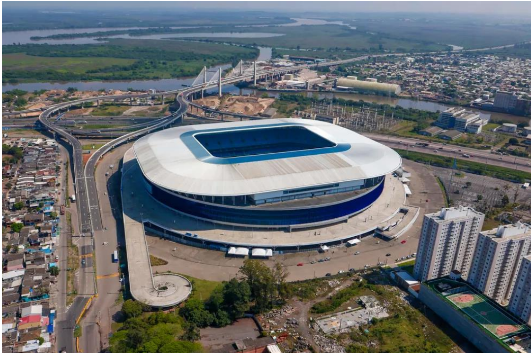
Imagem 16: A Arena do Grêmio. No lado esquerdo da foto, casas e comércios da Vila Farrapos. Ao lado direito, torres do Condomínio Liberdade. Na parte superior, elevados que dão acesso à BR-448, que desponta ao fundo da tela, cortando o município de Canoas. Foto: Luciano Lanes/ Arquivo PMPA 29 .
