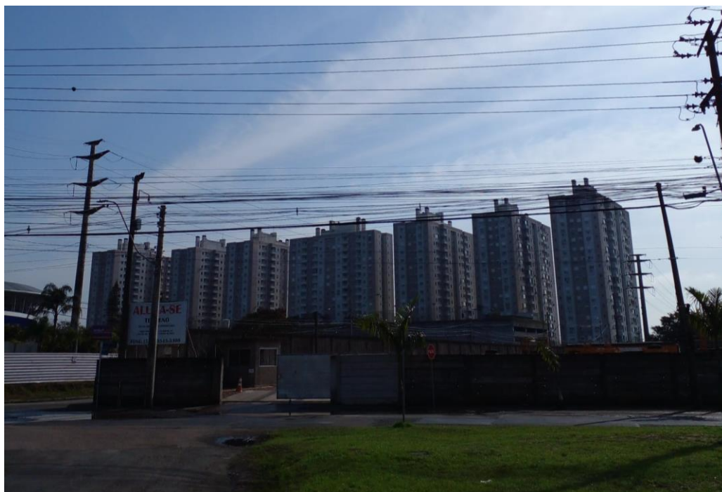
Imagem 19: Torres do Condomínio Liberdade. Julho de 2022 (acervo do autor).
