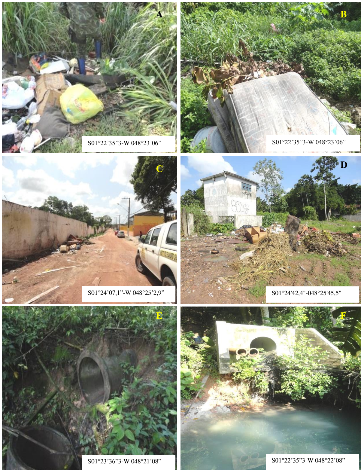
Figura 26. Insuficiência de saneamento básico no entorno do PEUT, limite entre os municípios de Belém e Ananindeua (Estado do Pará, Brasil): A a D- Acúmulo de resíduos sólidos domiciliares no entorno do parque; E e F- pontos de lançamentos de esgoto nos mananciais do Utinga.
