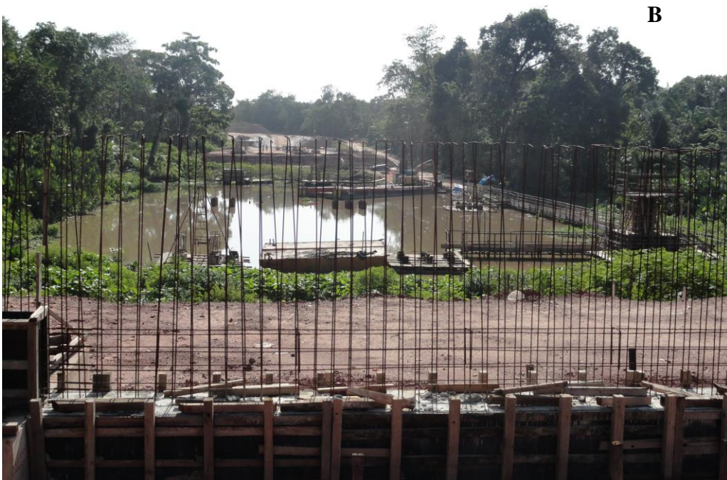
Figura 30. Obras de prolongamento da Avenida João Paulo II nas proximidades dos Mananciais do Utinga, limite entre os municípios de Belém e Ananindeua (Estado do Pará, Brasil): A- obra vista do Lago Água Preta, onde a separação ocorre por um “jardim” de macrófitas; B- Obra sobre o Lago Bolonha. Fotos: Autor.
